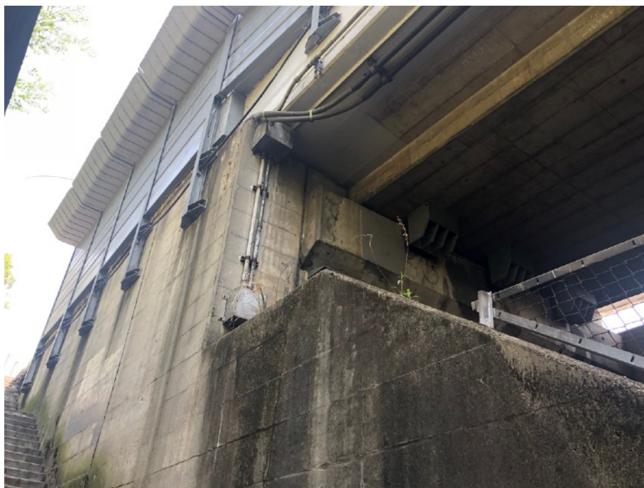
図 3.1：高速道路の外側の無骨な様子 (筆者撮影)
