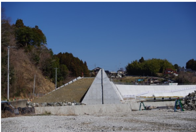
図 3.6：津波被災地に建設されつつある防潮堤 断面が見えている (筆者撮影)
