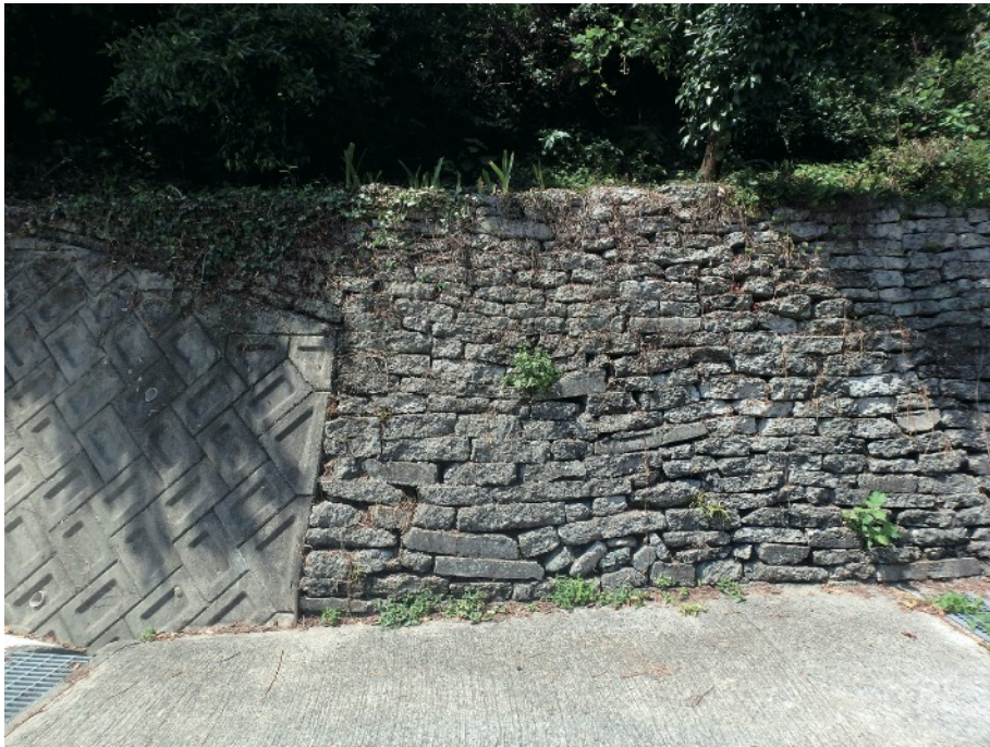
図 5.18：ハイブリッド石積みの例。破碎コンクリート舗装コバ積み（筆者撮影）
