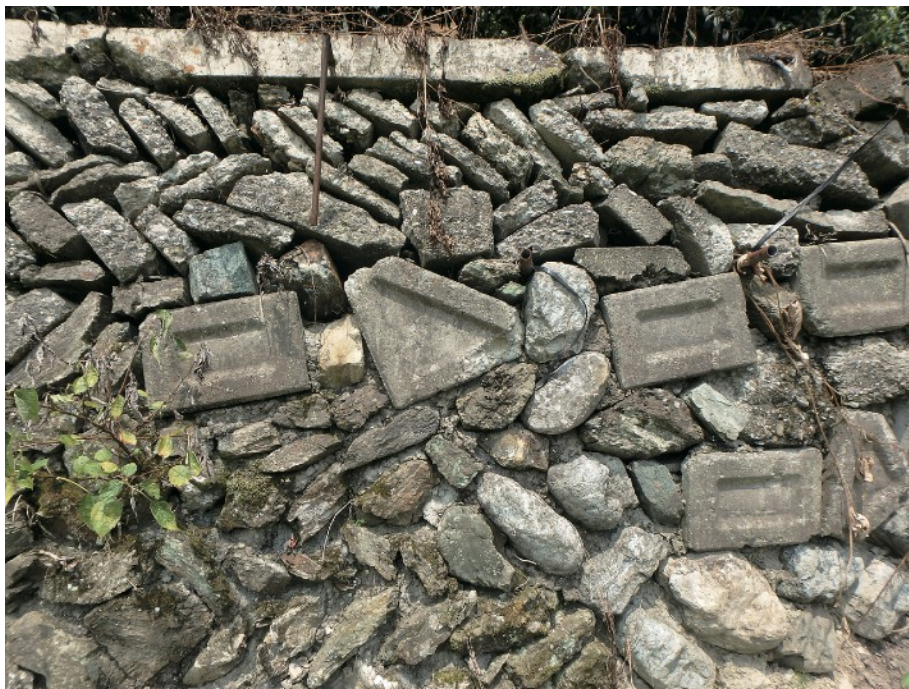
図 5.19：ハイブリッド石積みの例（筆者撮影） 自然石モルタル留め+PC間地石+破碎コンクリート舗装コバ積み+天端PC板押さえ
