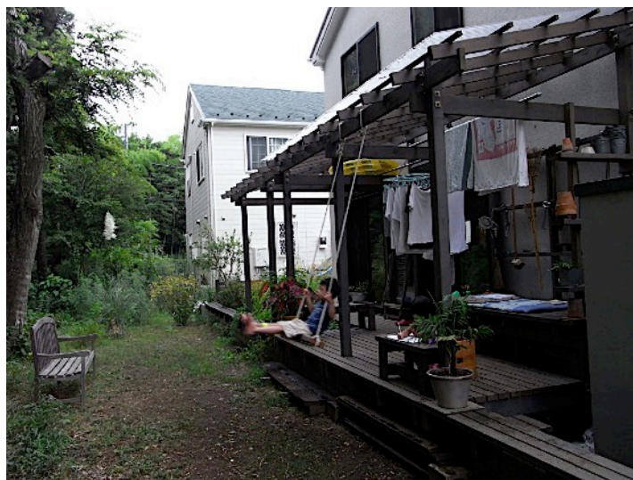
図 4.18：完成したデッキ（筆者撮影）
