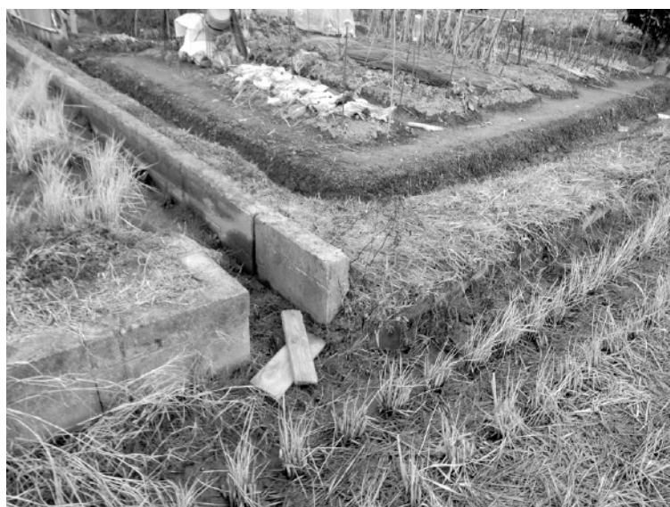
図 4.11：奈良盆地の用水路で水の回路を操作する板 (筆者撮影)
