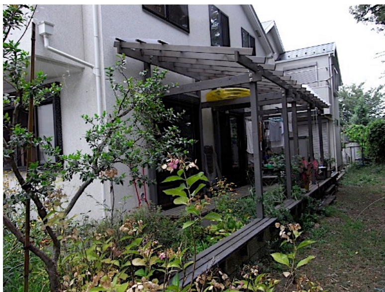
図 4.19：完成したデッキ（筆者撮影）
