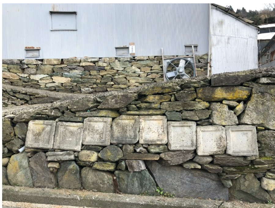
図 5.23 : ハイブリッド石積みの例
