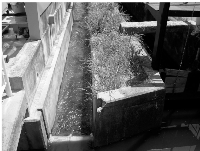
図 4.10：奈良盆地の用水路で水の回路を操作する板 (筆者撮影)
