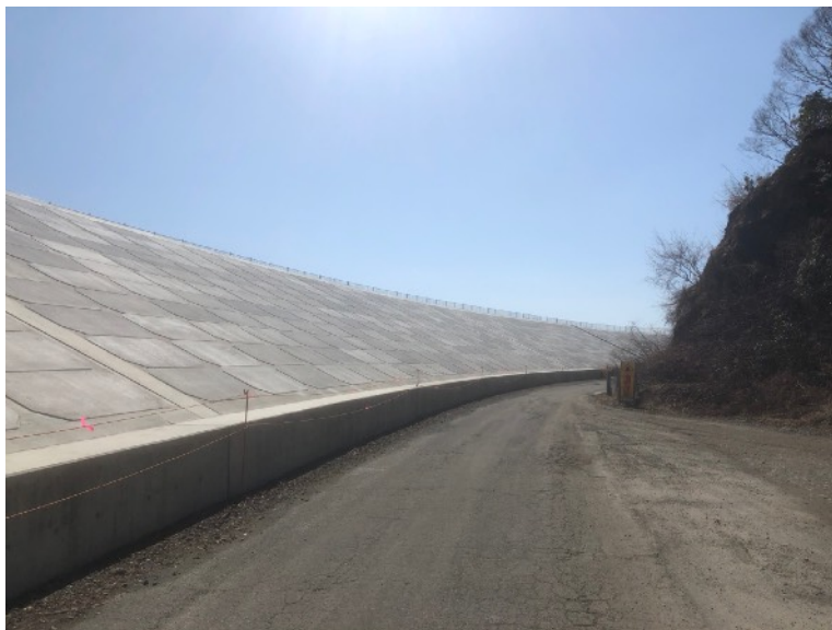
図 3.5：津波被災地に建設されつつある防潮堤 陸地側から (筆者撮影)
