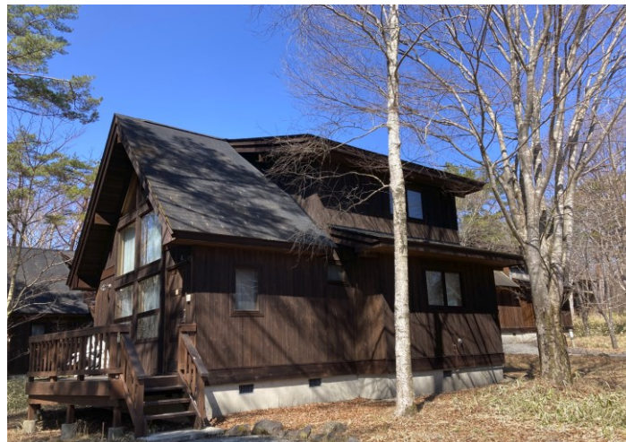
図 26 設置屋根写真1
