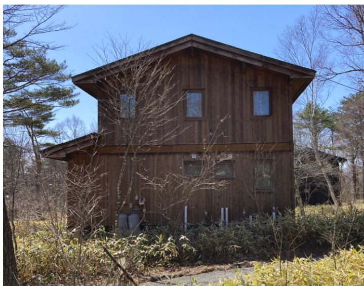
図 27 設置屋根写真 2
