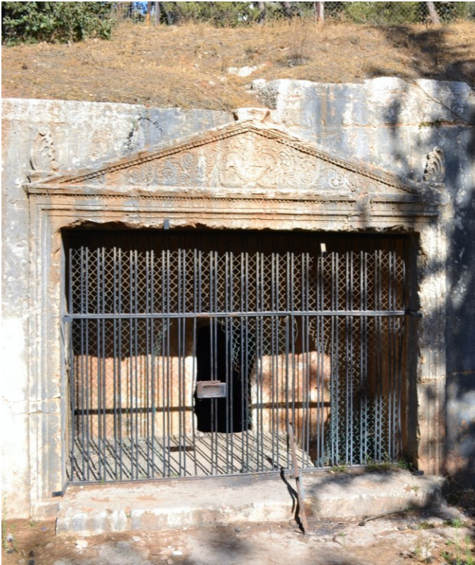
図9. ギリシア建築要素を取り入れたファサード、 サンヘドリンの墓
