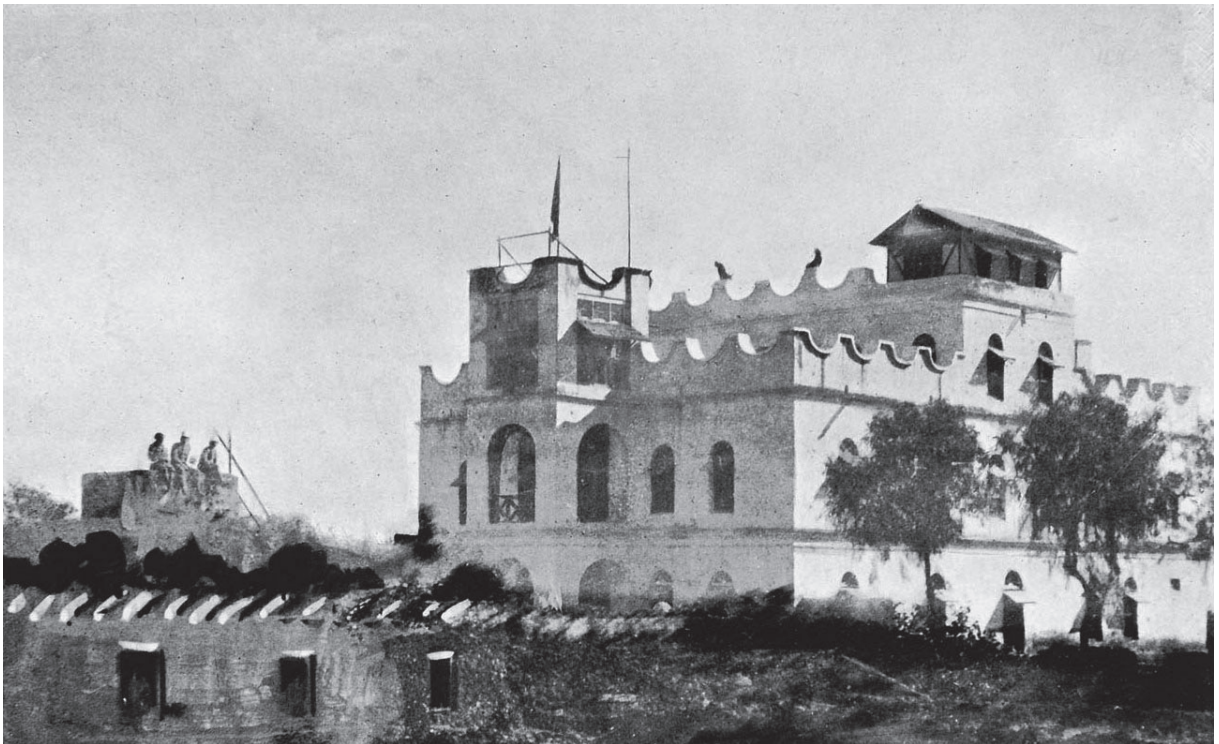
Fig. 1-69 Ras Makonnen New Palace, 1902
