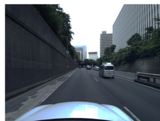
かすれた白線, 補修痕
