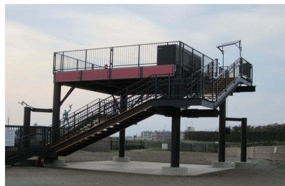
津波避難タワー
