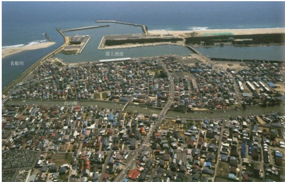
図 4-2 沿岸地域の写真（宮城県名取市）被災前 2007 年 5 月 7)
