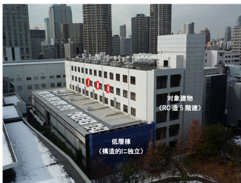
図 4.1 対象建物 (損傷を付与した柱を赤丸で示す)
