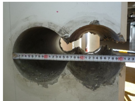
(d) コア抜き後の柱の状況
