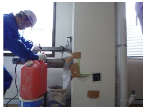
(b) コア抜き状況
