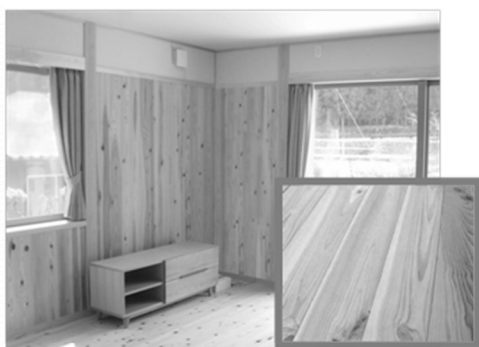
写真1. 床・壁に無垢材を使用している部屋
