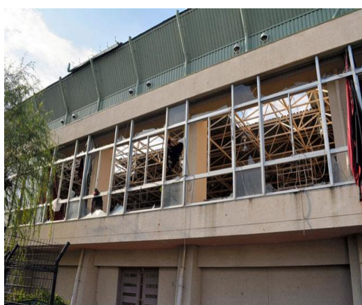
※震災後の体育館の写真。
