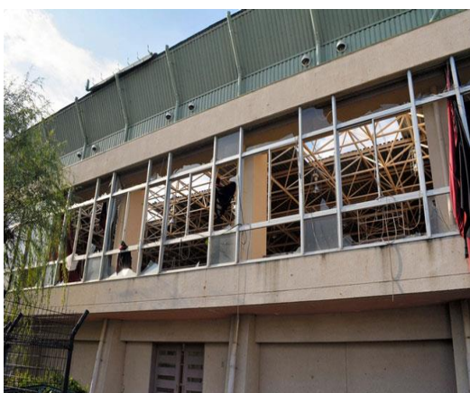
※震災後の体育館の写真
