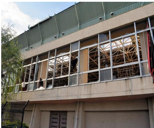
※震災後の体育館の写真
