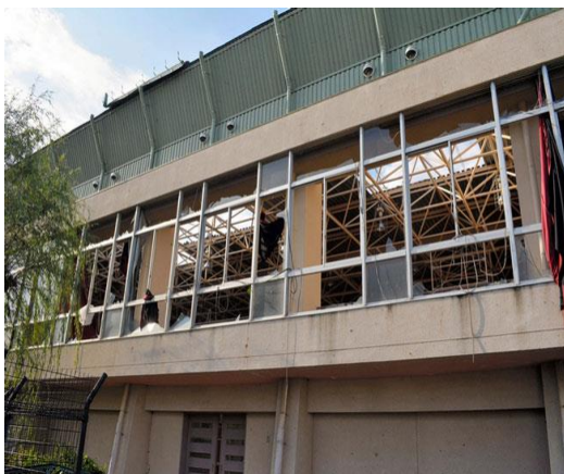
※震災後の体育館の写真。
