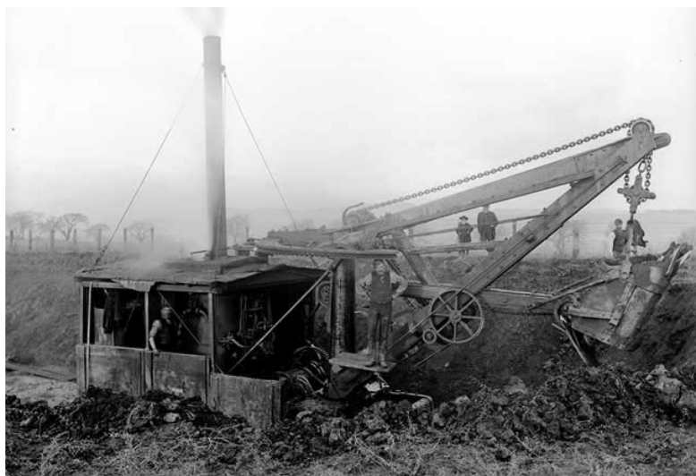
図 1-1 1835年米国 W.T. Otis 発明の蒸気ショベル
