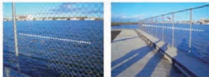
写真1 大森湾における津波の痕跡（フェンスに残る痕跡）
