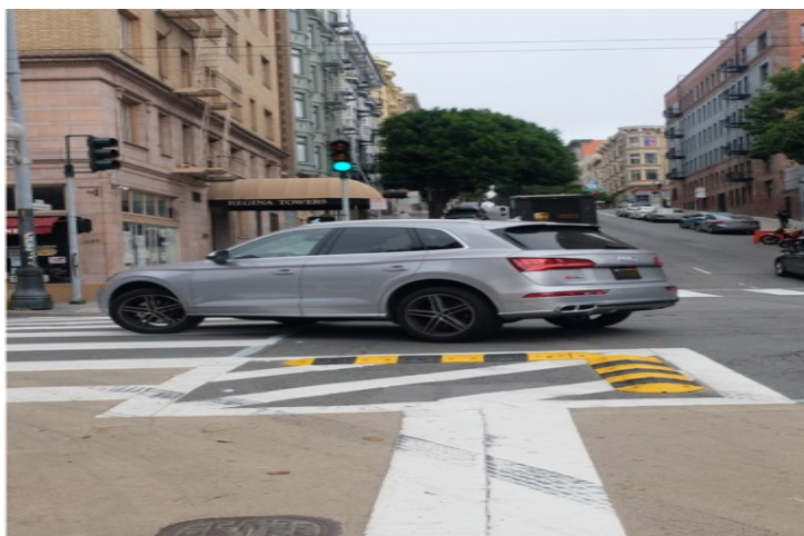
図 12 90^\circ でカーブするようウェッジを設置 (The Safer Inspections Project, 2021)
