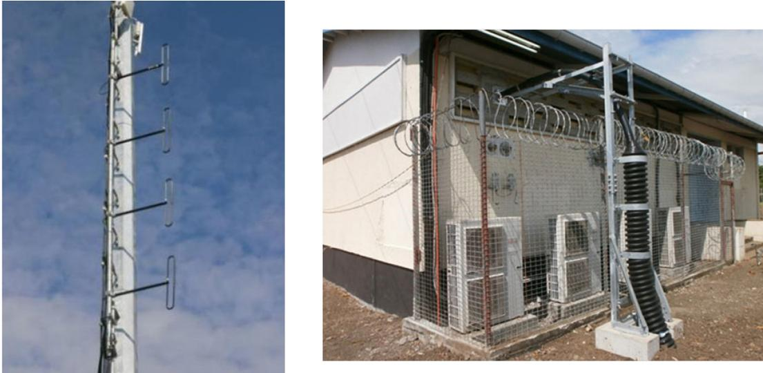
図 1-5 ソロモン諸島に配備された VHF 無線機連絡アンテナと給電施設[4]
