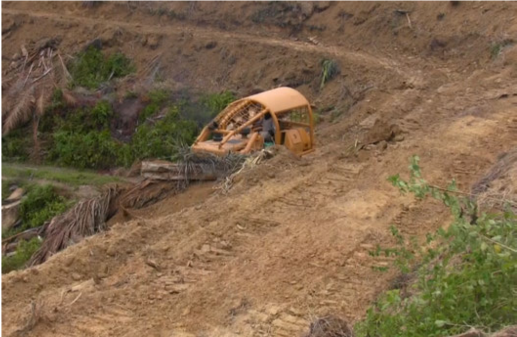
図 2-12 ブルドーザーによる造成
