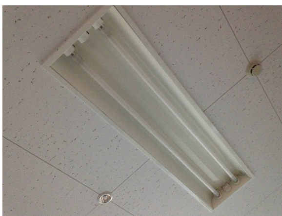
図 3-8 蛍光灯を設置した天井の様子 （同等の部屋の写真）
