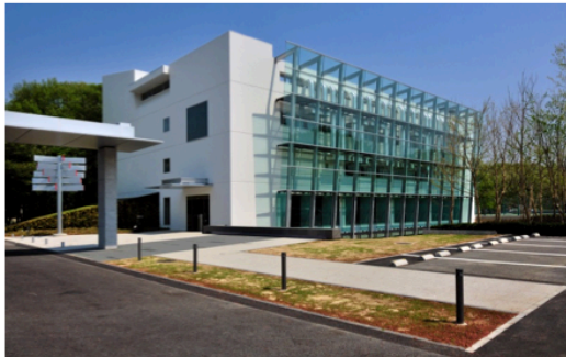
<写真> 大林組技術研究所材料化学実験棟 (旧本館コンバージョン)
