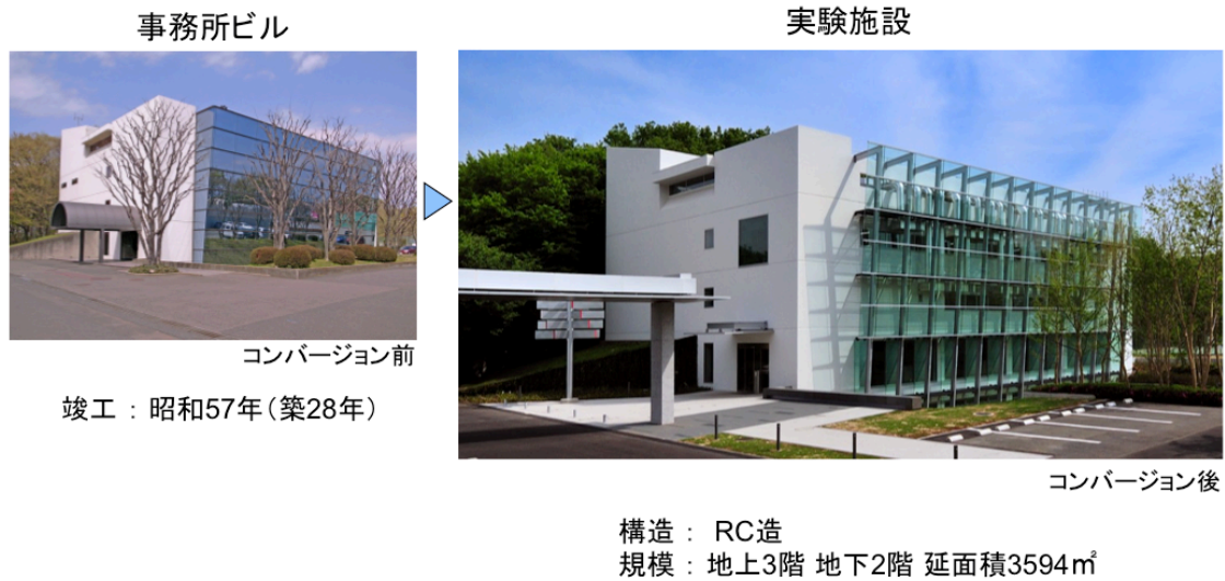
図 2.11 大林組技術研究所材料化学実験棟 外観写真
