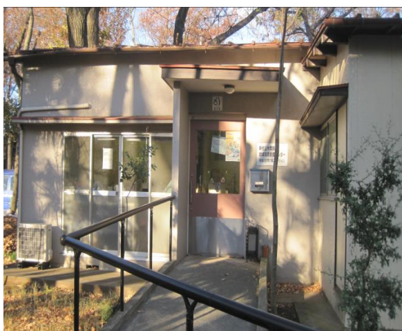
訪問介護ステーション 正面玄関入口
