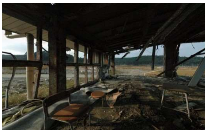
図 B-2 : 宮城県南三陸町戸倉小学校体育館
