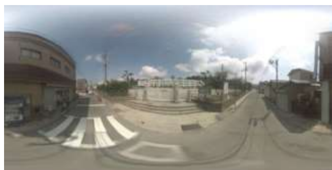
図 8-8：被災前の宮城県石巻市門脇町門脇小学校前
