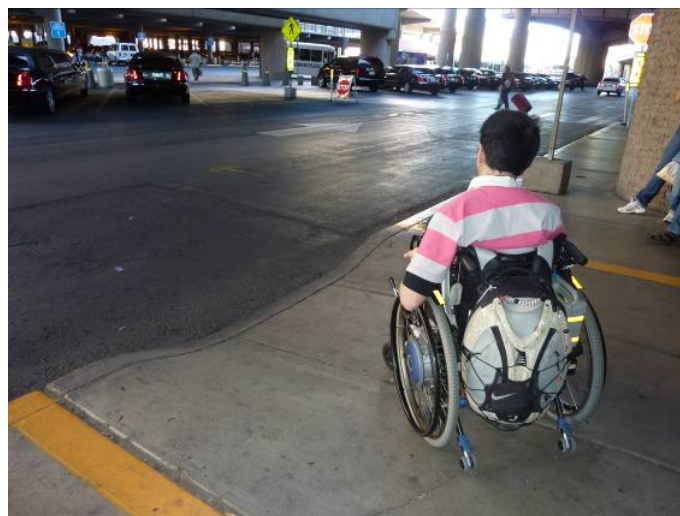
付図 2-2 ラスベガス空港内の歩道と車道の段差の様子
