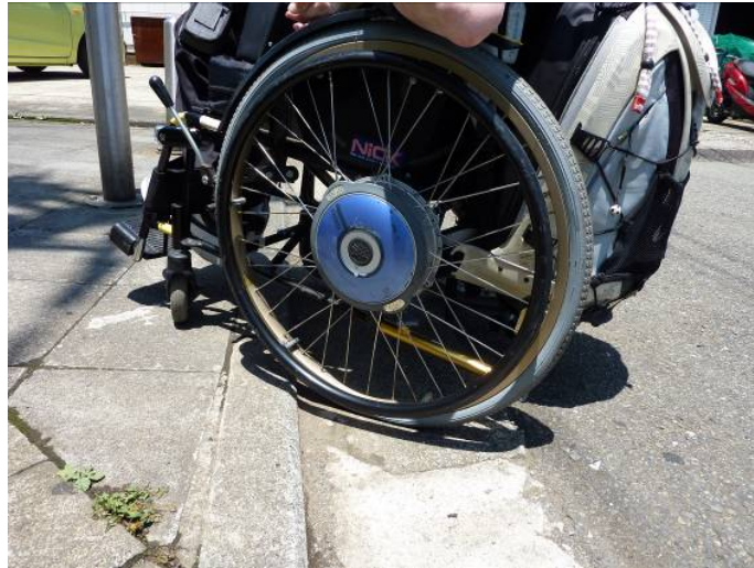
図 2-43 街中でよく見られる車道と歩道の段差
