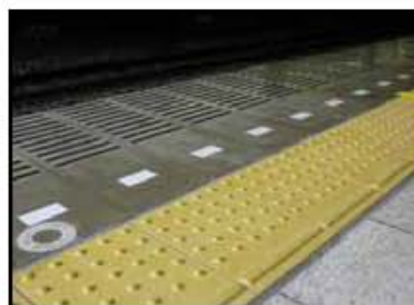
内方線付き 点状ブロック
