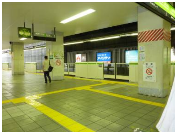
図 2-16 JR 目黒駅に設置されたホームドア
