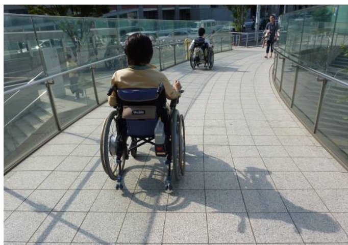
図 3-3 協生館2階のスロープ
