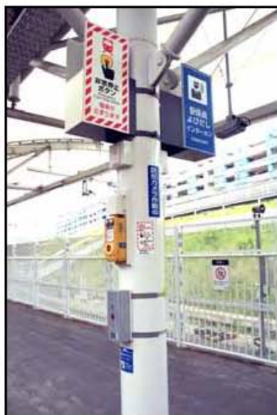
ホームの非常停止ボタン
