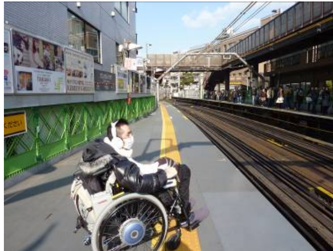
図 2-13 東急東横線代官山駅の工事中のホームの様子
