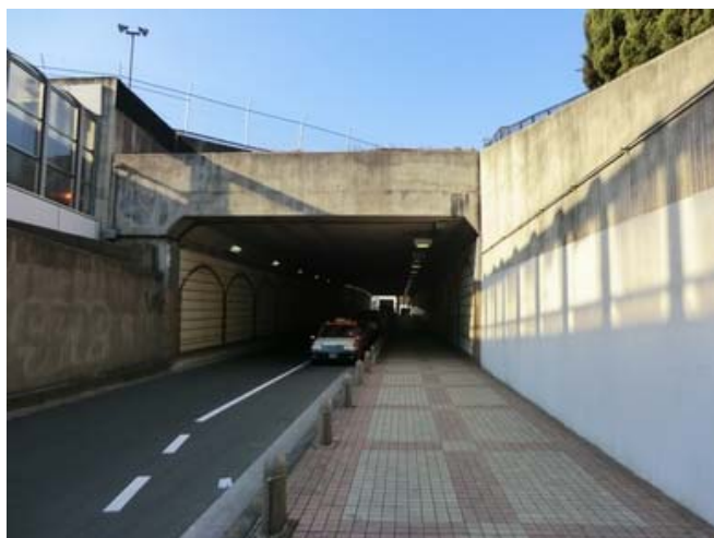
図 4.1.2-1 六本木トンネル 出口付近
