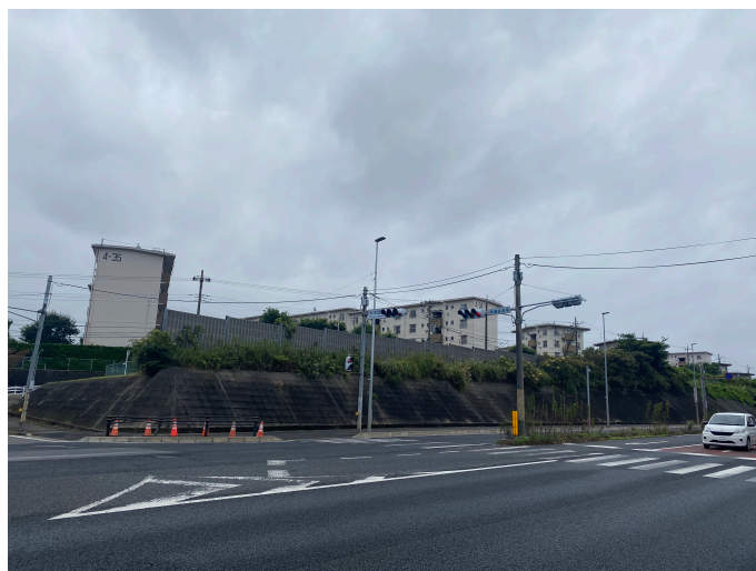
図 1.5 国道 16 号線から撮影した米本団地外観
