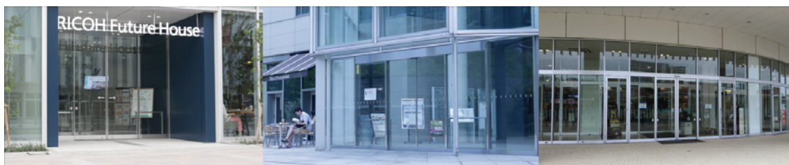
図 1.1: 商業施設のエントランスの自動ドア
