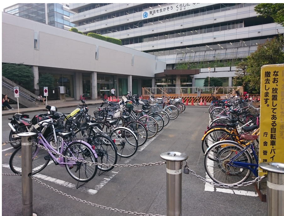
図 4.12: 区役所前広場の整備工事の様子 広場中央の花壇を取り壊している（写真中央）
