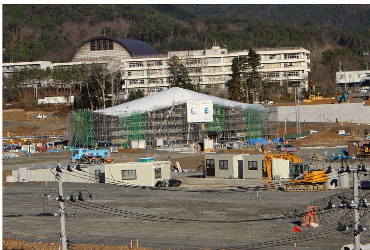
図 2.15: 2014 年 12 月現在の JR 女川駅の工事の様子
