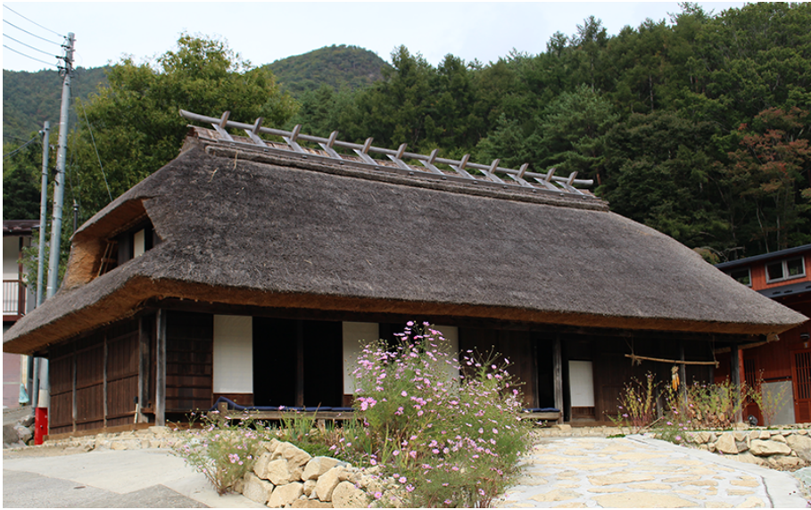
図 3.27: ターゲットとなる古民家である藤原邸
