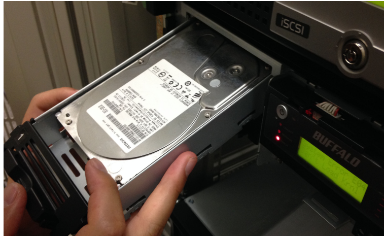
図 4.2: トラブルシューティングに関する作業の様子
