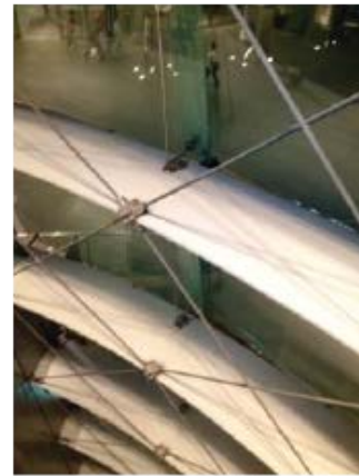
内部ガラス壁面
