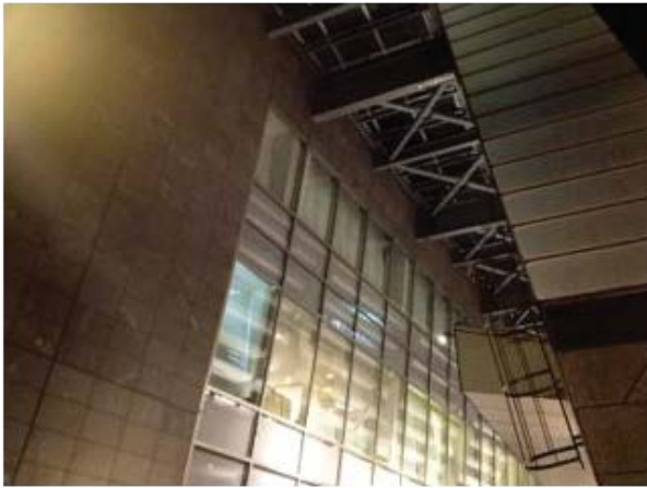
高い吹き抜け
