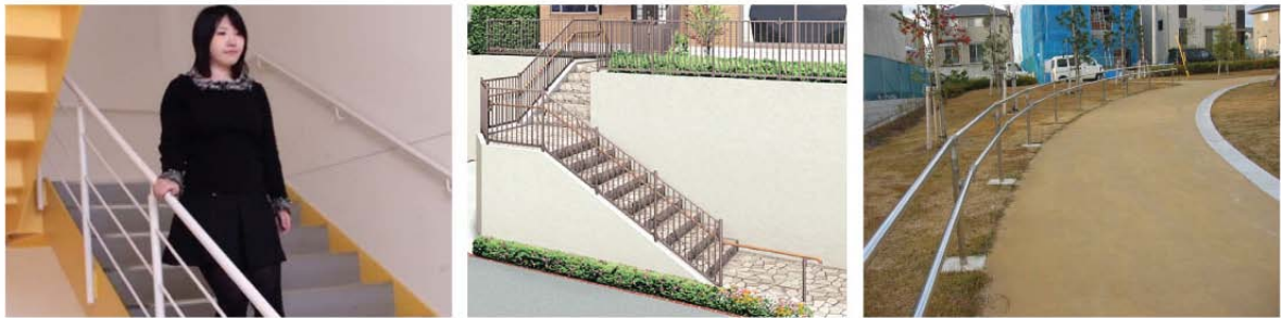
図 3.2 経路を示す手すり
