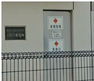
元住吉変電所
