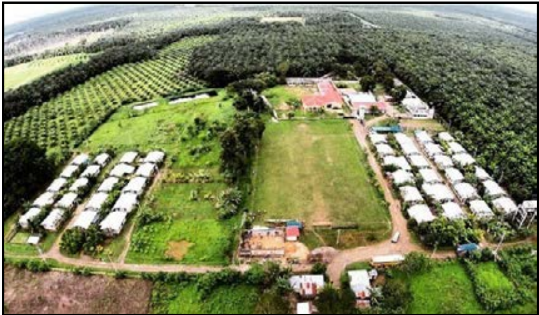
図 3.2 SHH の職員やボランティアが施設の子供たちと建設した村の様相 (出典 : http://shhkids.org/projects/ )
