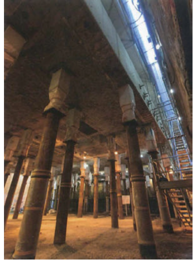
写真 免震装置を設置するための 地下工事の様子
