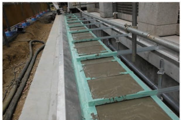
写真 5.1.59 エクspansion床構築 4
