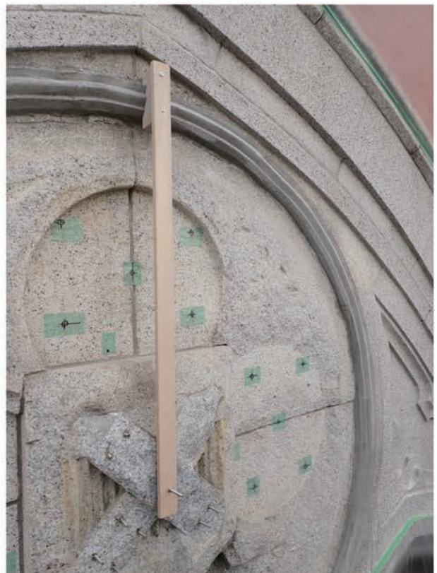
写真 5.3.37 円形モルディング用の型を取り付けた状態
