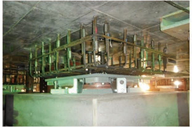
写真 5.1.44 免震上部基礎配筋
