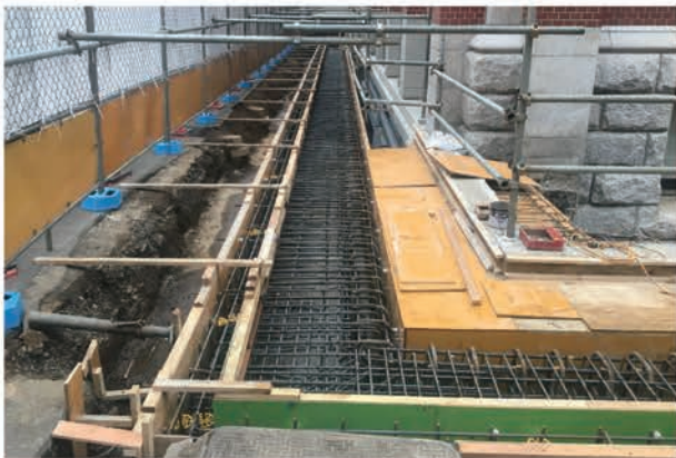
写真 5.1.54 エクspansion躯体構築 1
