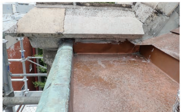
写真 5.2.11 軒先樋のやり替え(修理後)
