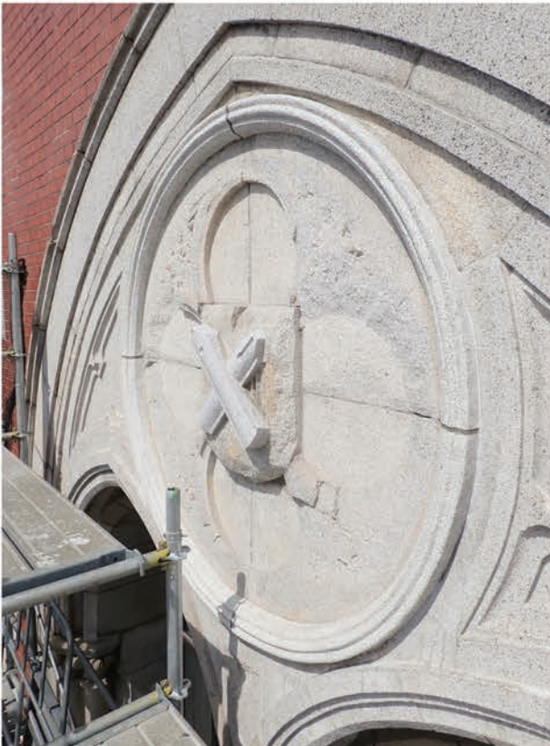
写真 5.3.47 円形モールディング・ペンマーク全景 (修理後)
