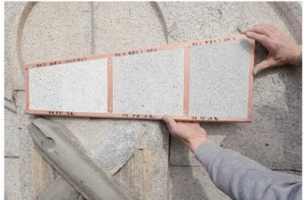
写真 5.3.44 擬石塗り色合わせサンプル（ペンマーク）
