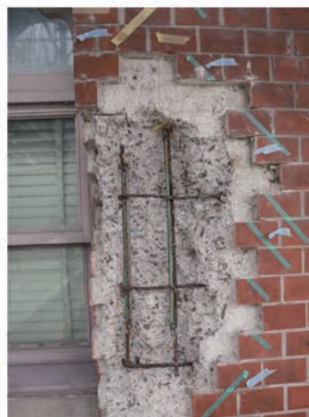
写真 5.3.6 躯体の脆弱部 鉄筋の錆を除去し鉄筋を追加挿入した
