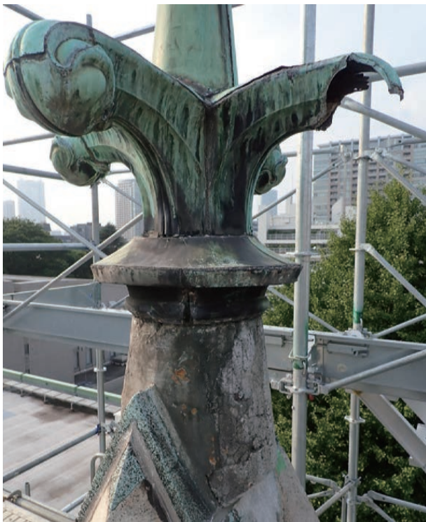
写真 5.2.13 第一書庫北面東寄りフィニアル（修理前）
