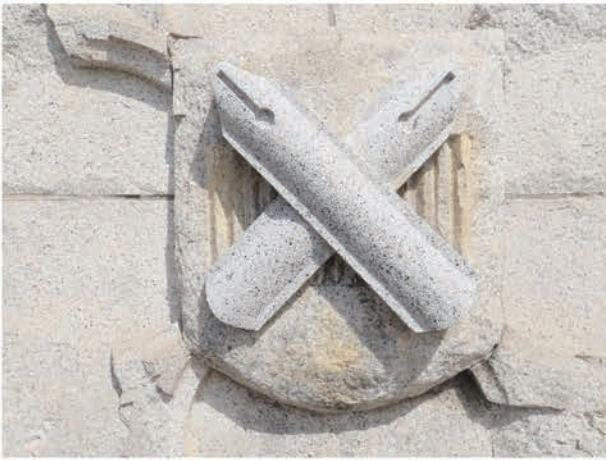
写真 5.3.46 ペンマーク (修理後)
