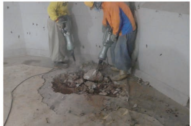
写真 5.1.4 土間スラブ解体 2
