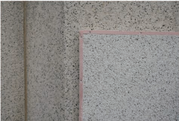
写真 5.3.52 擬石塗りサンプルと壁面を比較し、配合を決定した
