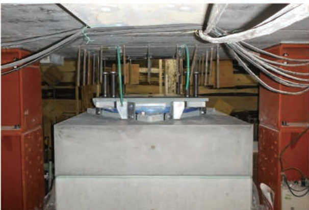
写真 5.1.43 免震装置設置
