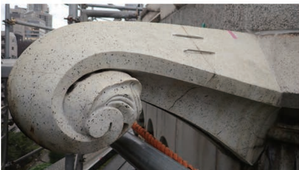
写真 5.3.15 楔による固定 北側（修理後）
