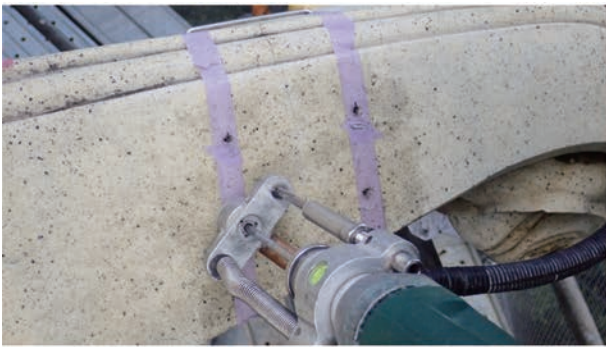
写真 5.3.13 湿式二軸低騒音ドリルで削孔
