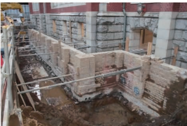
写真 5.1.9 煉瓦擁壁掘削
