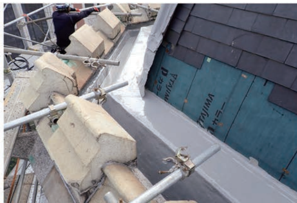
写真 5.2.21 八角塔 ウレタン防水を施した
