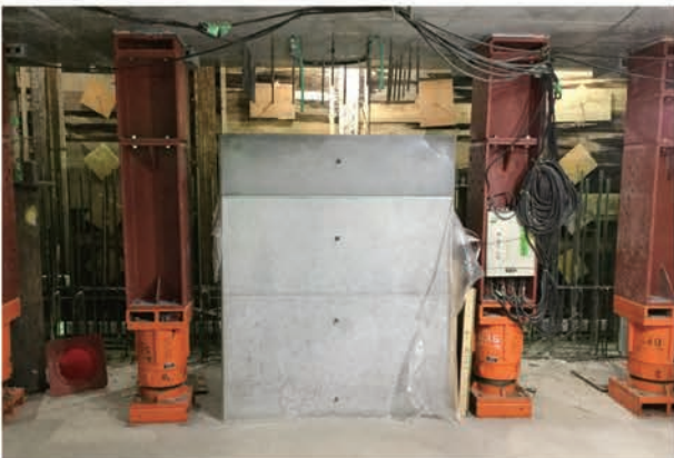
写真 5.1.42 免震下部基礎打設完了
