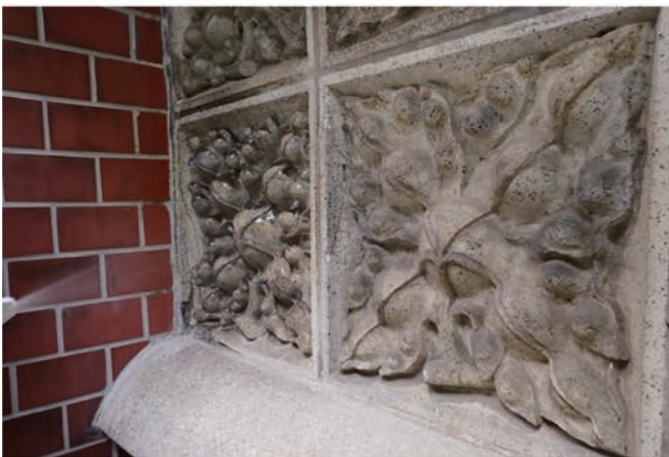
写真 5.3.10 洗浄する面を水で湿らせる
