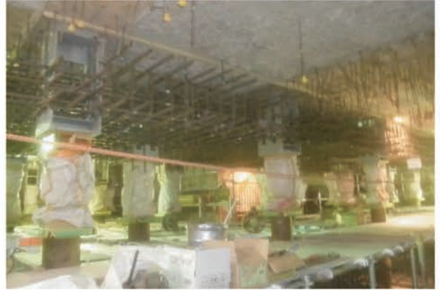
写真 5.1.33 既存基礎下配筋1
