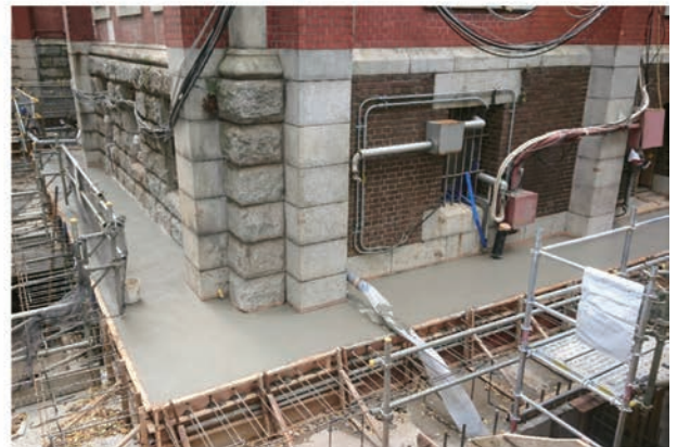
写真 5.1.17 補強添え梁打設
