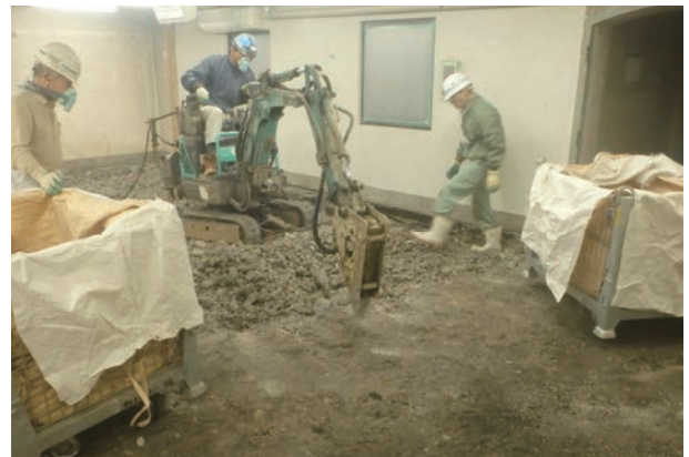
写真 5.1.3 土間スラブ解体 1
