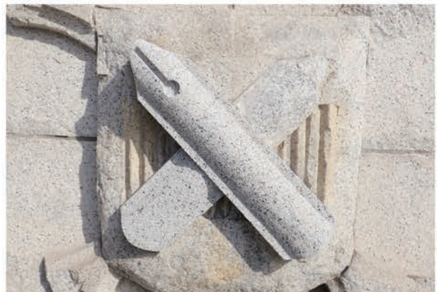
写真 5.3.43 ペンマーク 東側上部以外の擬石塗りが完了した状態
