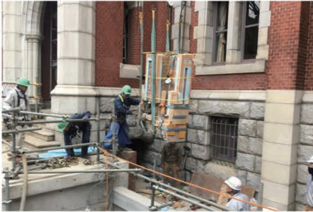
写真 5.1.52 煉瓦擁壁の復元 1
