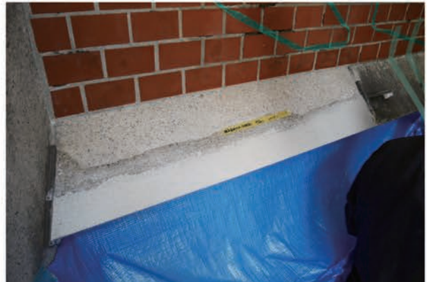
写真 5.3.58 洗い出し完了
