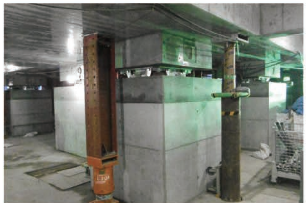
写真 5.1.47 免震上部基礎躯体完了2
