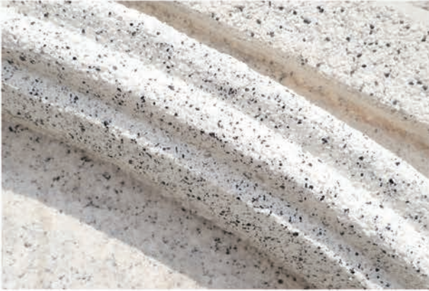
写真 5.3.45 円形モールディング 部分 (修理後)
