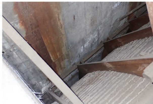
写真 5.4.9 大階段室 ヴォールト天井木摺 (小屋裏から)
