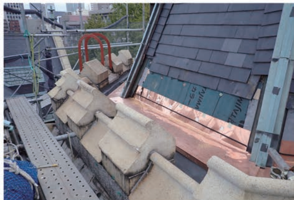
写真 5.2.22 八角塔 屋根立ち上がり部分 銅板の立ち上がりを高くし防水性を高めた
