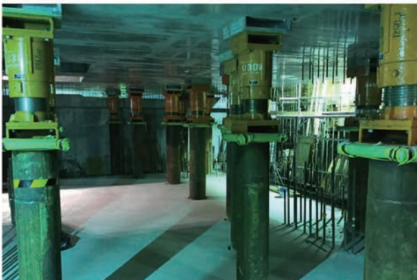
写真 5.1.38 仮受け支柱工事 2
