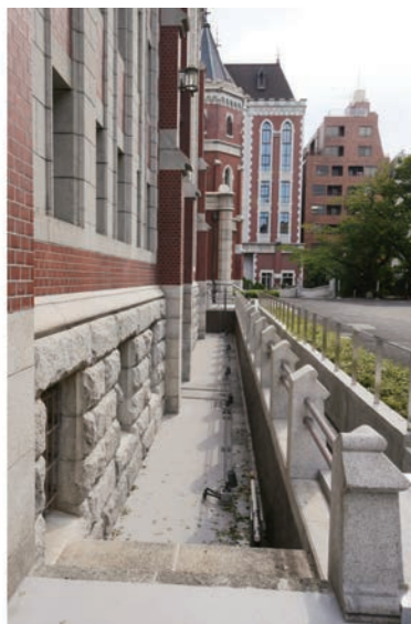
写真 5.5.2 ドライエリア (竣工)
