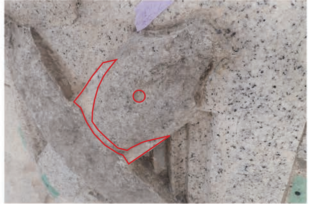
写真 5.3.35 東側上部に当初の加工表面が残存 (赤枠内)
