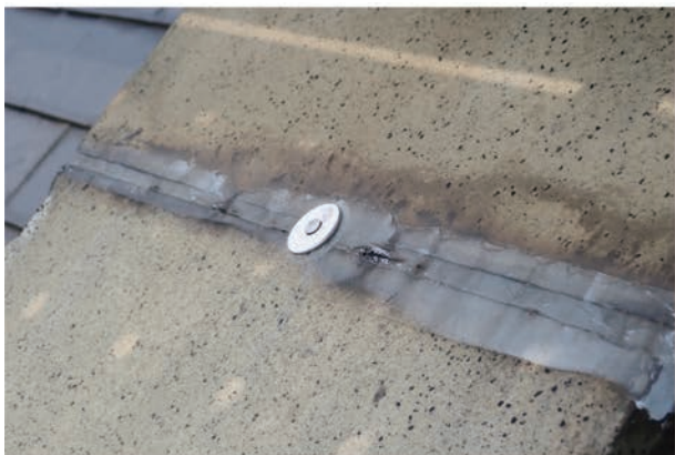
写真 5.3.18 ワッシャー取付完了
