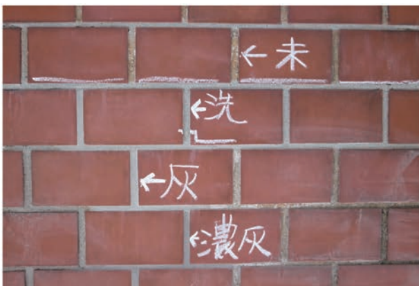
写真 5.3.7 目地を洗浄した後、色調合わせを行った
