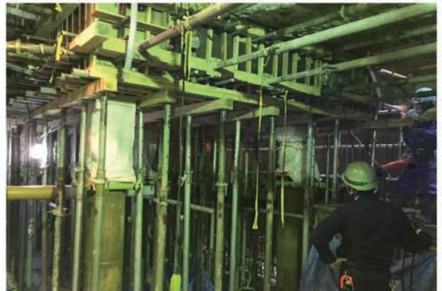
写真 5.1.35 既存基礎下打設
