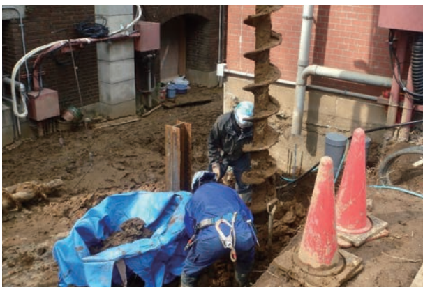
写真 5.1.2 山留め杭工事 2
