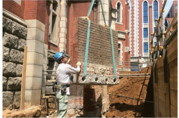
写真 5.1.10 煉瓦擁壁分割保管
