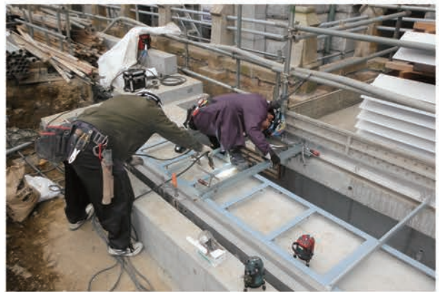
写真 5.1.57 エクspansion床構築 2
