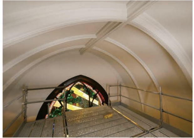
写真 5.4.12 大階段ホール ヴォールト天井 (修理後)
