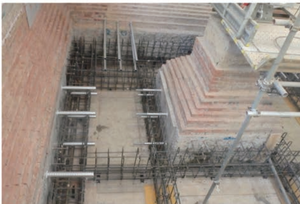
写真 5.1.14 補強添え梁配筋
