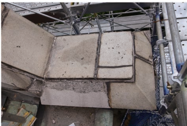
写真 5.3.21 固定が不安定だった笠木 北面
