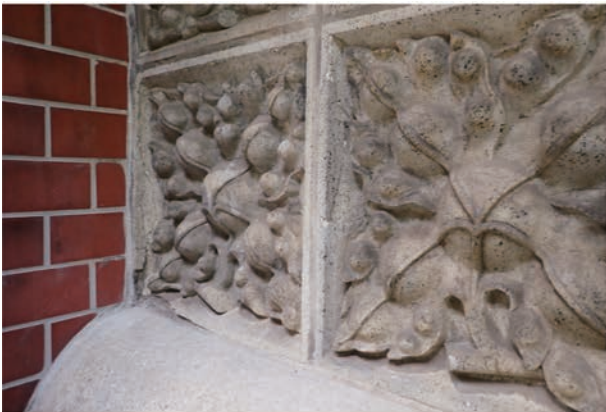
写真 5.3.9 テラコッタ装飾タイル（洗浄前）
