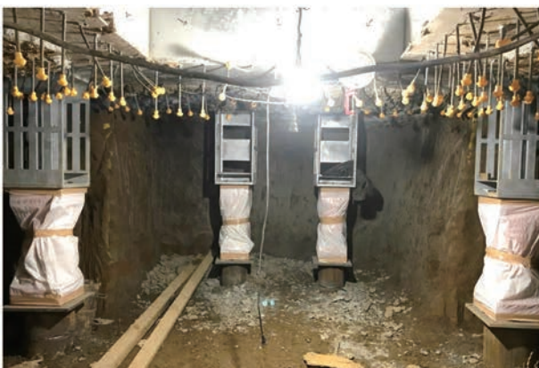
写真 5.1.26 仮受鋼管杭プレロード後
