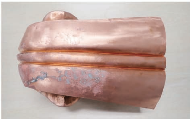
写真 5.2.16 復原したフィニアル修理部分 上面(上)、側面(中央)、下面(下)
