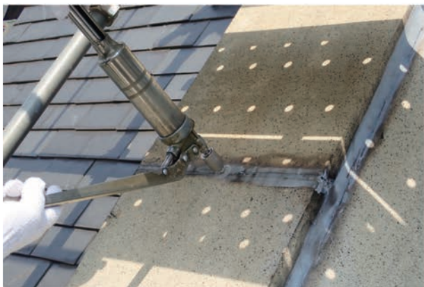
写真 5.3.17 目地にワッシャーを取り付ける
