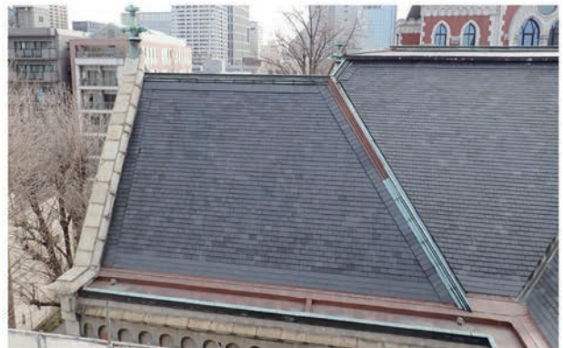
写真 5.2.12 第一書庫屋根 全景 東北部(修理後)
