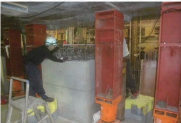
写真 5.1.41 ベースプレート設置
