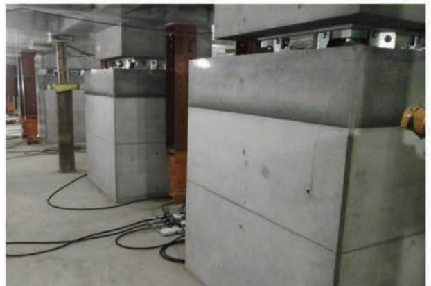
写真 5.1.46 免震上部基礎躯体完了1
