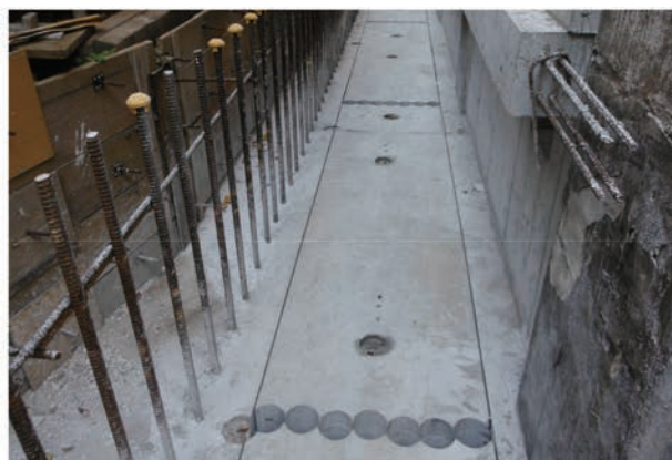
写真 5.1.50 水平拘束スラブ撤去 1
