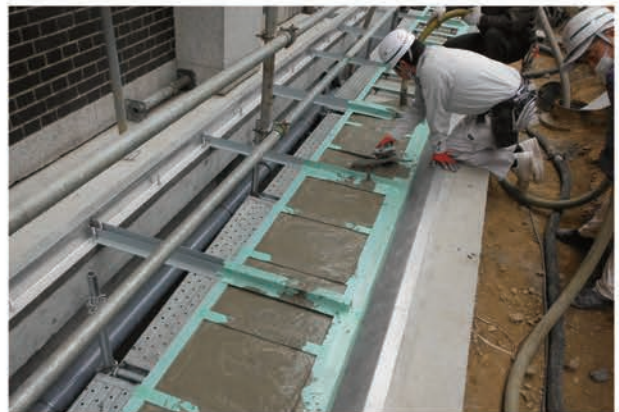
写真 5.1.58 エクspansion床構築 3
