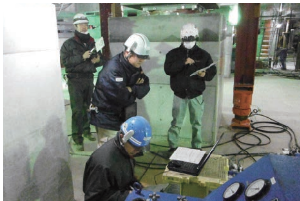
写真 5.1.49 ジャッキダウン状況
