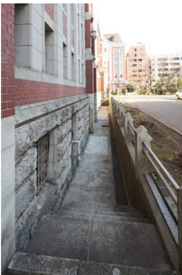
写真 5.5.1 ドライエリア 西から (修理前)
