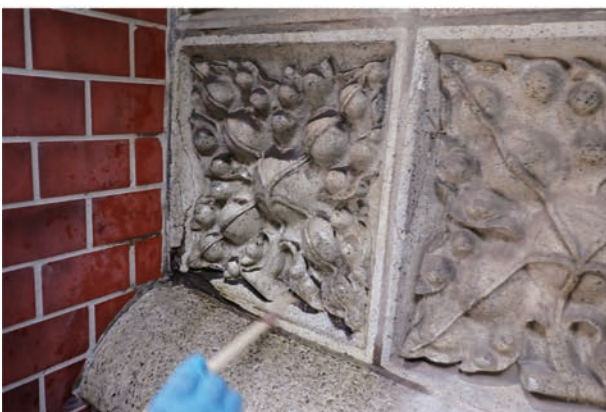
写真 5.3.11 テラコッタ装飾タイル 薬剤の反応を見ながら洗浄する
