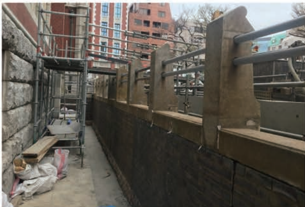
写真 5.1.53 煉瓦擁壁の復元 2
