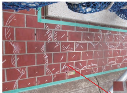
No.3 エポキシ樹脂注入後 チョークで囲った部分が樹脂注入後、 打検音に変化した箇所
