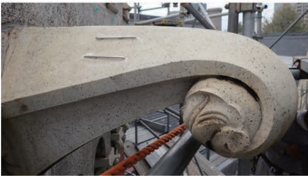
写真 5.3.14 楔による固定東側（修理後）
