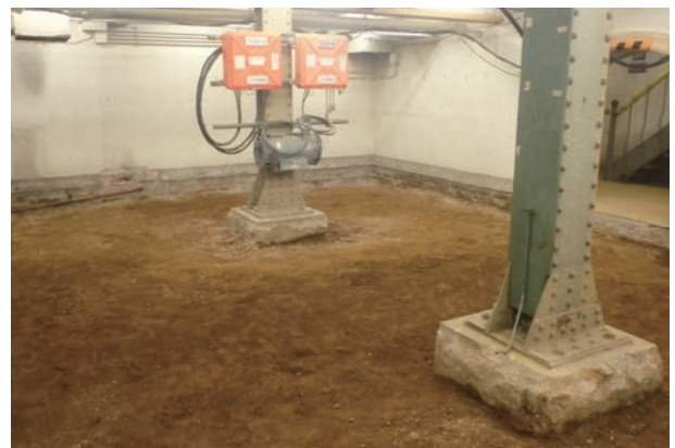
写真 5.1.5 土間スラブ解体後
