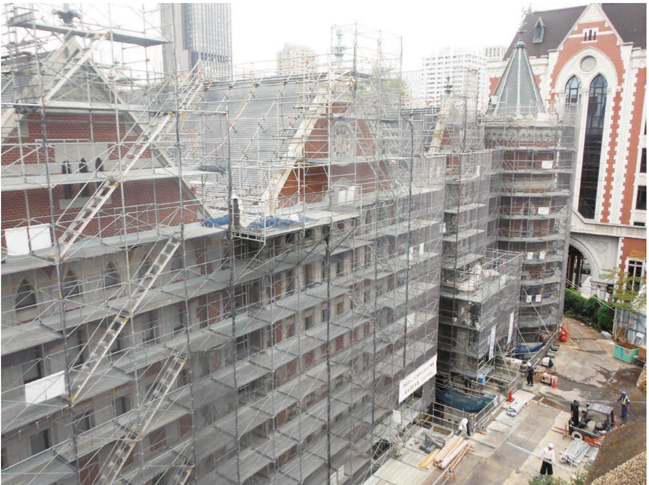
写真 5.3.61 工事中の旧館および第二書庫全景 南西から
