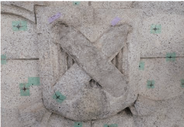
写真 5.3.32 ペンマーク既存補修擬石撤去
