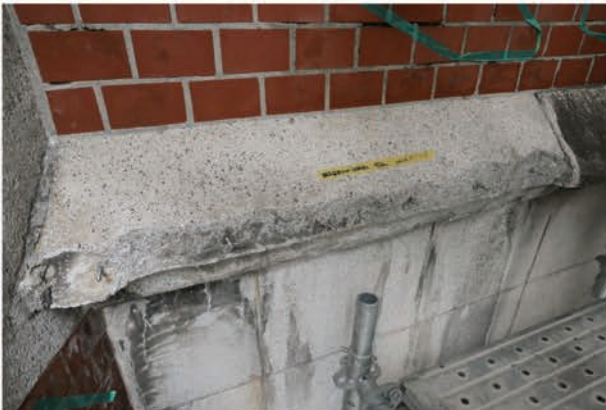
写真 5.3.53 石製コーニス欠損部に千鳥にピン打ち、ワイヤーを張った
