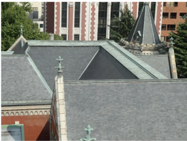
写真 5.2.2 第一書庫屋根 全景 東南部（修理前）
