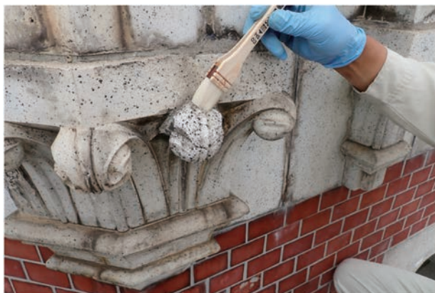
写真 5.3.60 損傷の個所に強化剤を含ました
