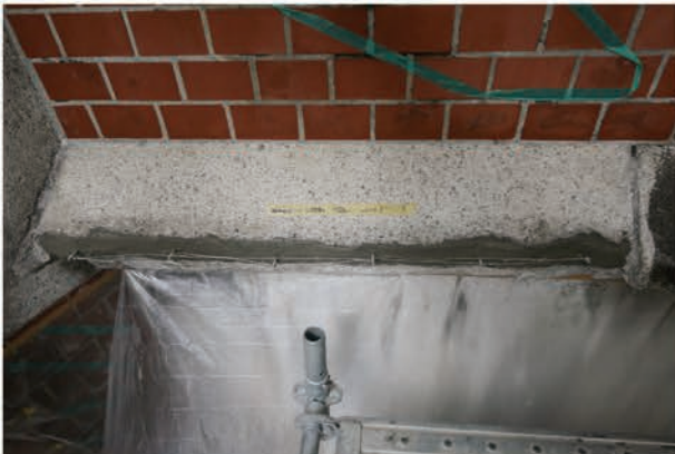
写真 5.3.54 ワイヤーにからめるように下塗りを行う
