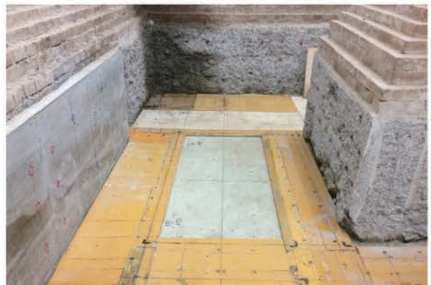
写真 5.1.12 基礎整形工事 2
