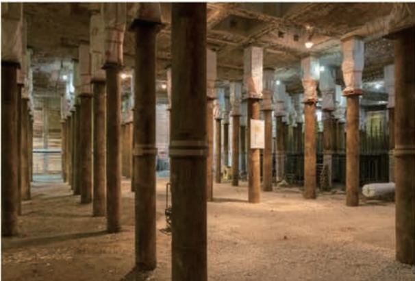
写真 5.1.30 3次掘削完了
