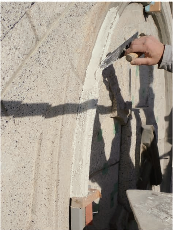
写真 5.3.40 上塗りをして再び型引きを行う
