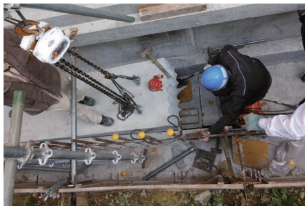
写真 5.1.51 水平拘束スラブ撤去 2
