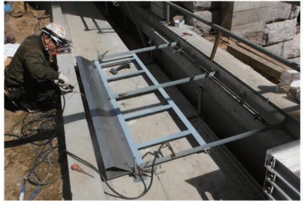
写真 5.1.56 エクspansion床構築 1
