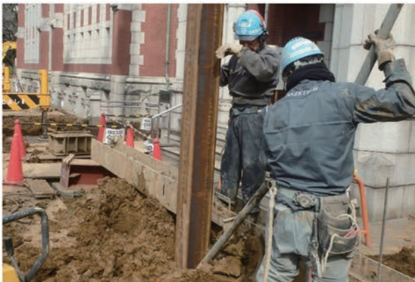
写真 5.1.1 山留め杭工事 1
