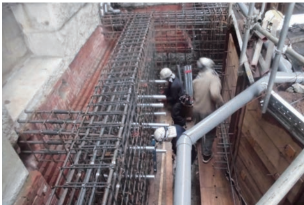
写真 5.1.15 補強添え梁配筋
