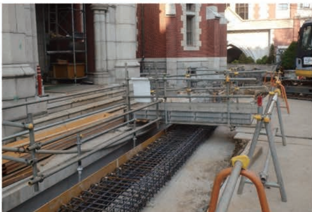
写真 5.1.55 エクspansion躯体構築 2
