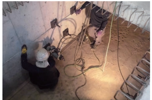
写真 5.1.18 PC鋼棒緊張
