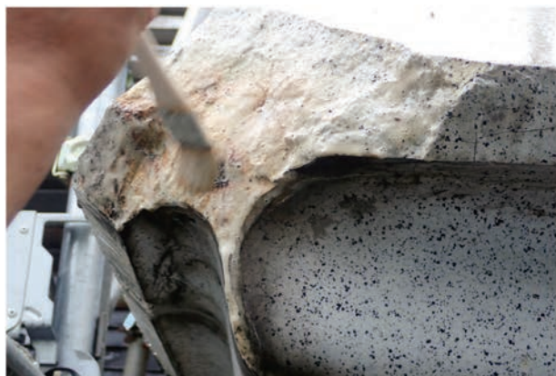
写真 5.3.25 薬剤で赤錆を黒錆に還元する
