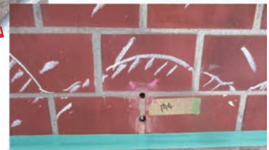
樹脂注入部 拡大 (内視鏡調査部)
