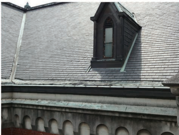
写真 5.2.3 谷線・軒先部分とドーマー窓廻りの納まり（修理前）
