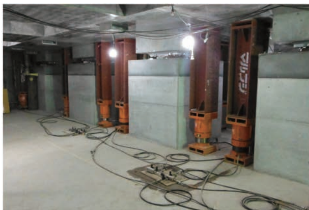
写真 5.1.48 ジャッキダウン配線
