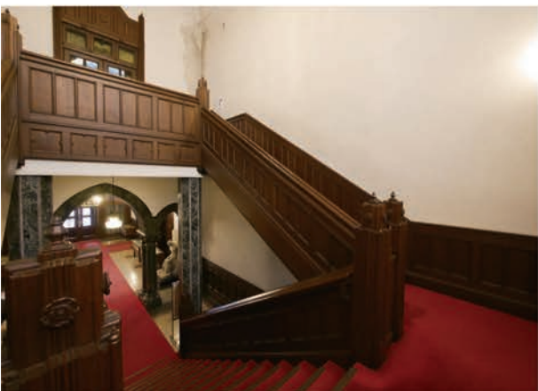
写真 5.4.11 大階段室 (修理前)
