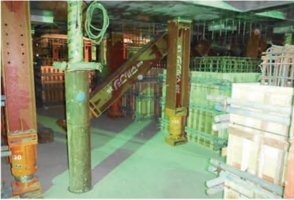
写真 5.1.40 免震下部基礎打設
