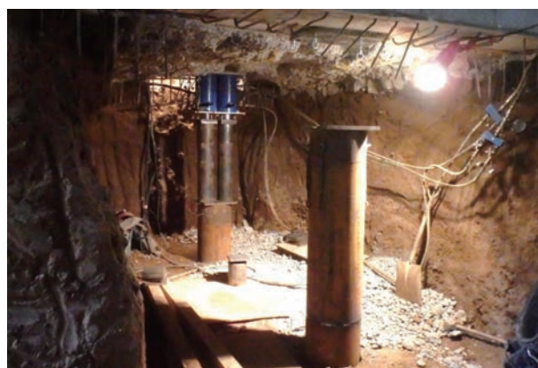
写真 5.1.23 仮受鋼管杭施工2
