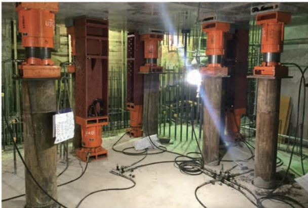
写真 5.1.37 仮受け支柱工事 1
