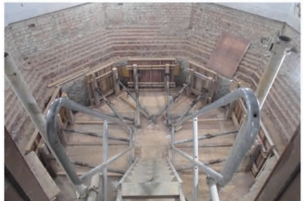
写真 5.1.11 基礎整形工事 1
