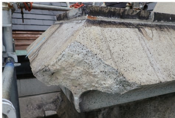
写真 5.3.27 疎水性モルタルで太納の表面を覆った
