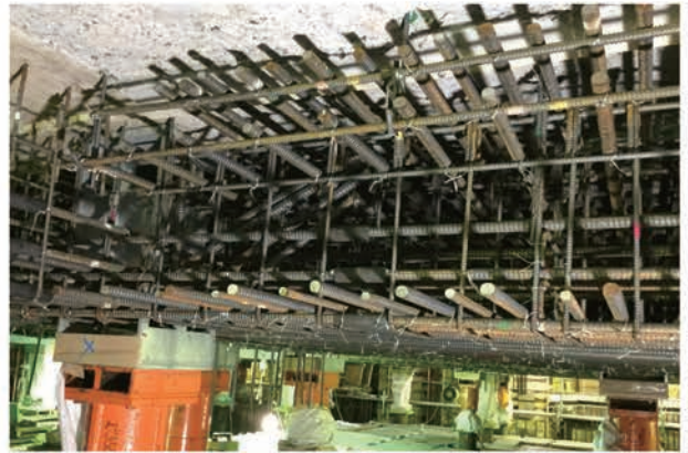
写真 5.1.34 既存基礎下配筋2
