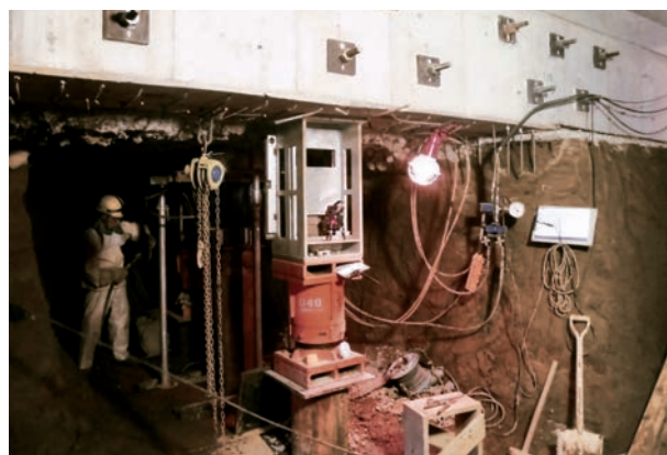
写真 5.1.24 仮受鋼管杭施工3
