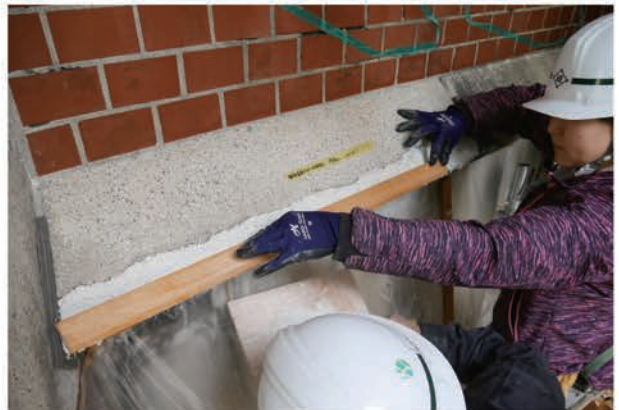
写真 5.3.57 上塗り後、角を型で押さえる
