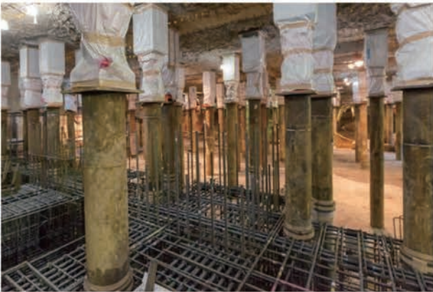
写真 5.1.31 基礎梁耐圧版配筋
