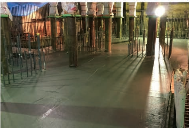
写真 5.1.32 基礎梁耐圧版打設
