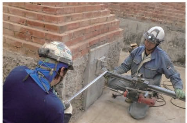
写真 5.1.13 コンクリートコアボーリング
