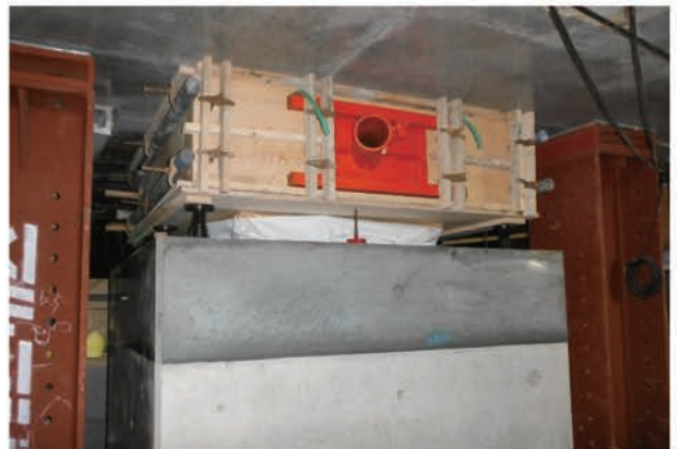
写真 5.1.45 免震上部基礎打設
