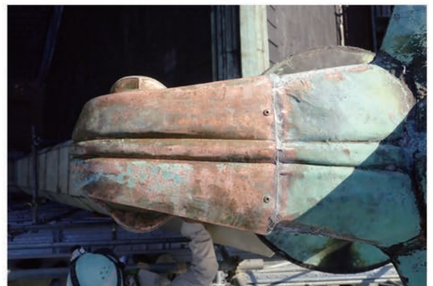
写真 5.2.18 修理箇所 上面
