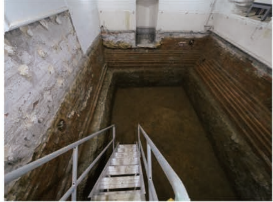
写真 4.2.18 倉庫(1) 布基礎 南から
