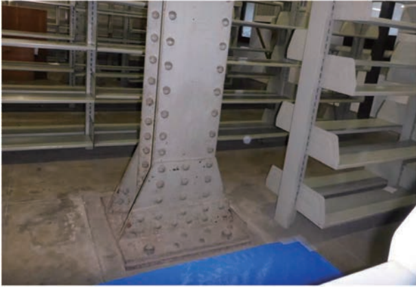
写真 4.4.1 第一書庫地下1階間柱
