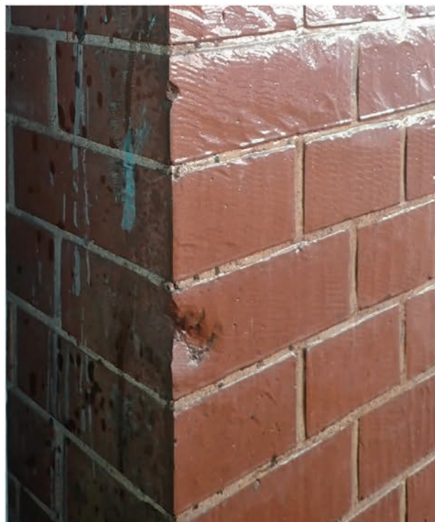
写真 4.3.5 橋台東端表積化粧煉瓦
