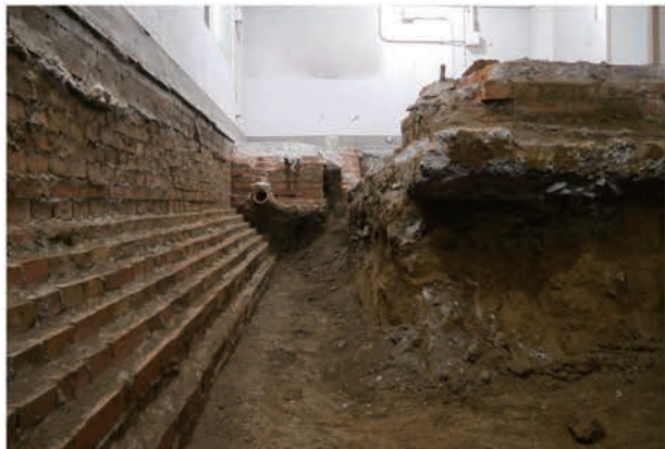
写真 4.9.11 機関室東半 北から
