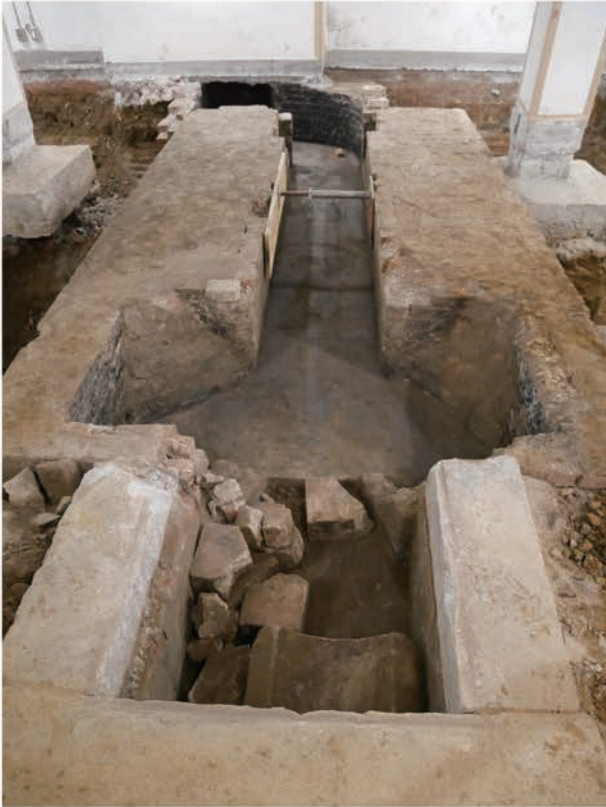
写真 4.9.4 機関室 ポイラー煙道 北から
