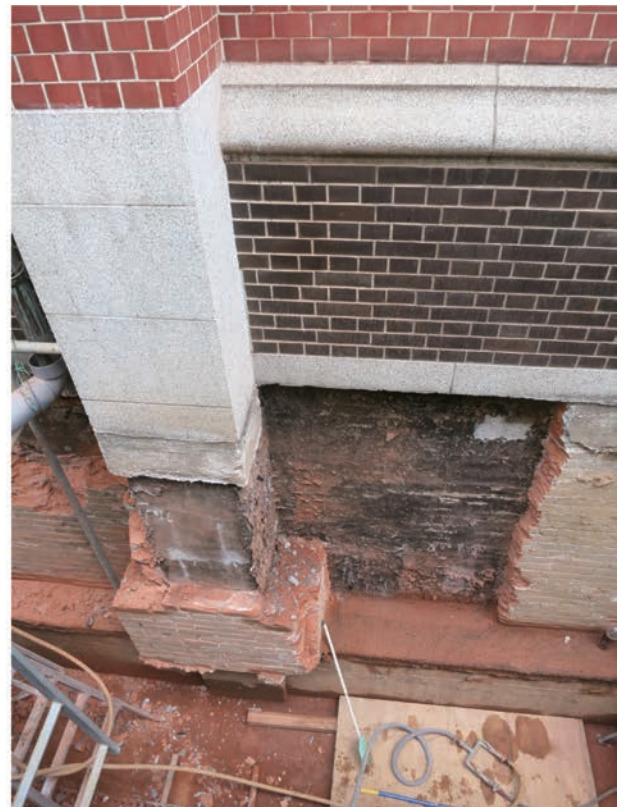
写真 4.2.23 第二書庫 西面外壁 基礎 上方から
