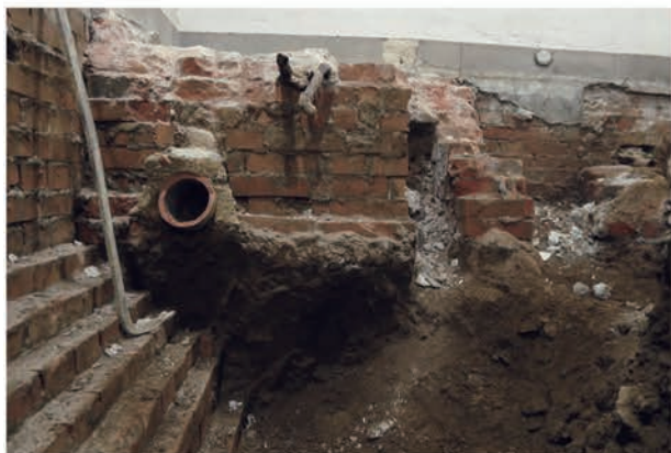
写真 4.9.13 煉瓦積貯水槽 基礎石を取り除いた状態 北から
