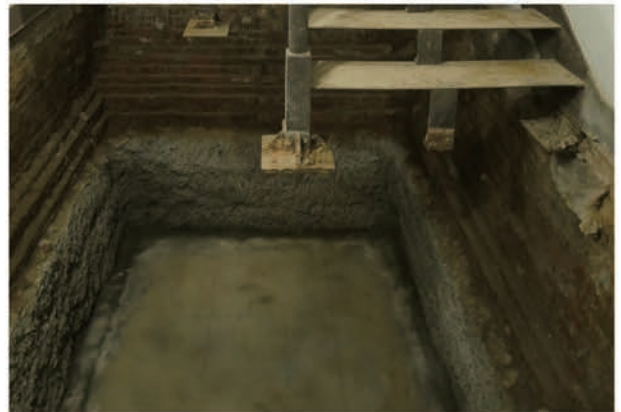
写真 4.2.19 階段室 布基礎 南から
