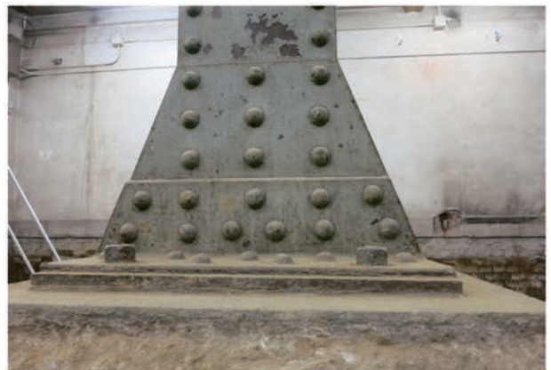
写真 4.2.13 第一書庫南室 独立基礎(東) 礎石上の鉄骨柱 西面
