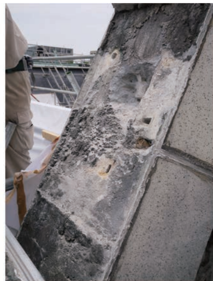
写真 4.5.1 上面の笠木を取り外した状態
