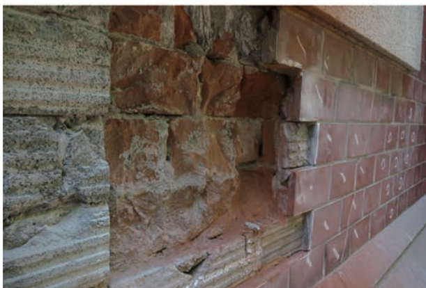
写真 4.3.1 旧館 東面外壁 下駄歯積
