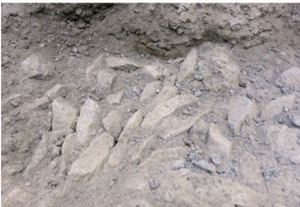
写真 4.2.3 第一書庫南室 独立基礎（西） 栗石 詳細
