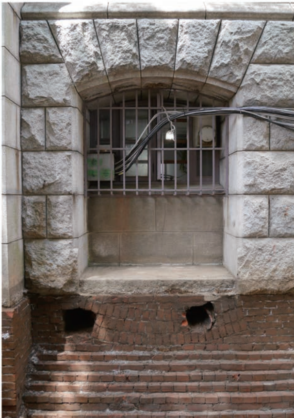
写真 4.3.7 旧館東面外壁開口部 インバート 現在は窓になっているが、当初は扉口だった
