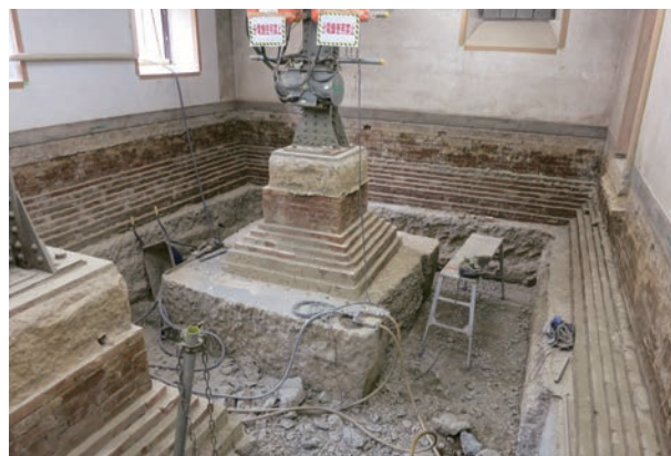
写真 4.2.1 第一書庫南室 免震工事に伴うコンクリート基礎の研り
