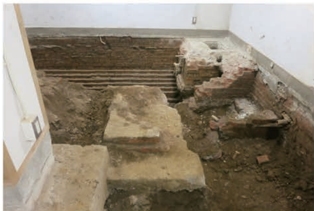
写真 4.9.12 煉瓦積貯水槽 西から
