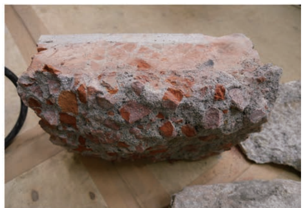
写真 4.5.6 地階床 煉瓦片入りコンクリート
