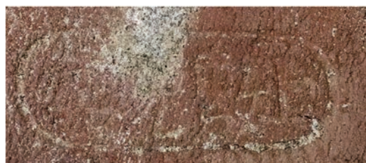
写真 4.3.11 普通煉瓦刻印「上敷免製」
