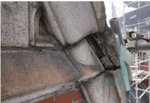
写真 4.5.3 側面の笠木を連結する鉄棒
