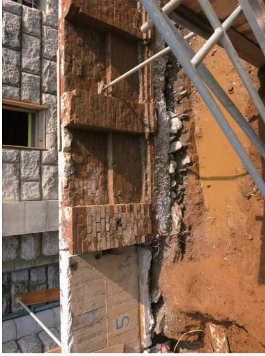
ドライエリア 擁壁 当初部分 (右) と増築部分 (左)
