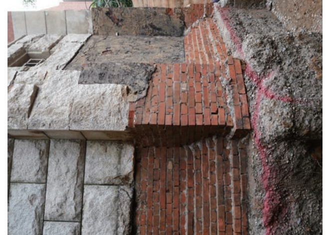
八角塔 外壁基礎
