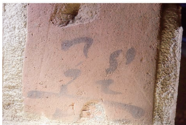
写真 4.3.15 ドライエリア壁で確認した墨書「巽?」
