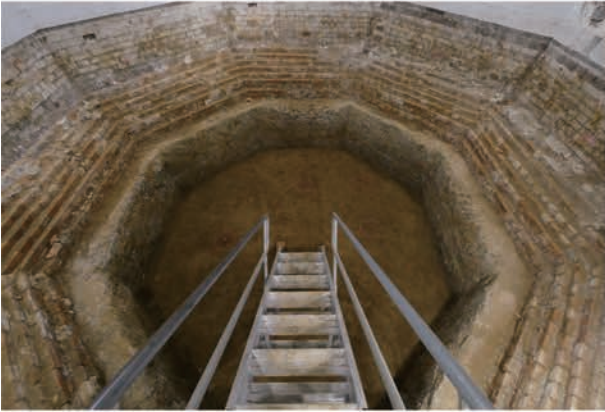
写真 4.2.15 八角塔 布基礎 北西から
