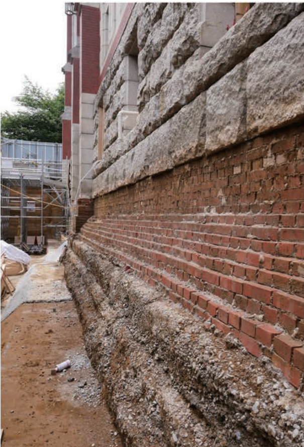
写真 4.2.17 南面西寄り外壁 基礎 東から
