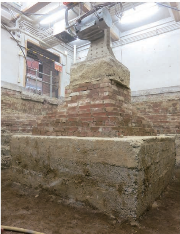
写真 4.2.11 第一書庫北室 独立基礎(東) 南西から
