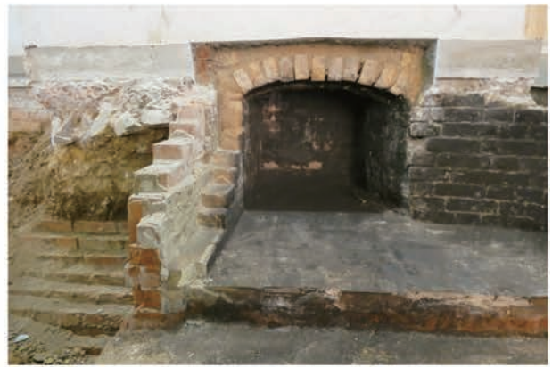
写真 4.9.9 煙道と煙突の接続部
