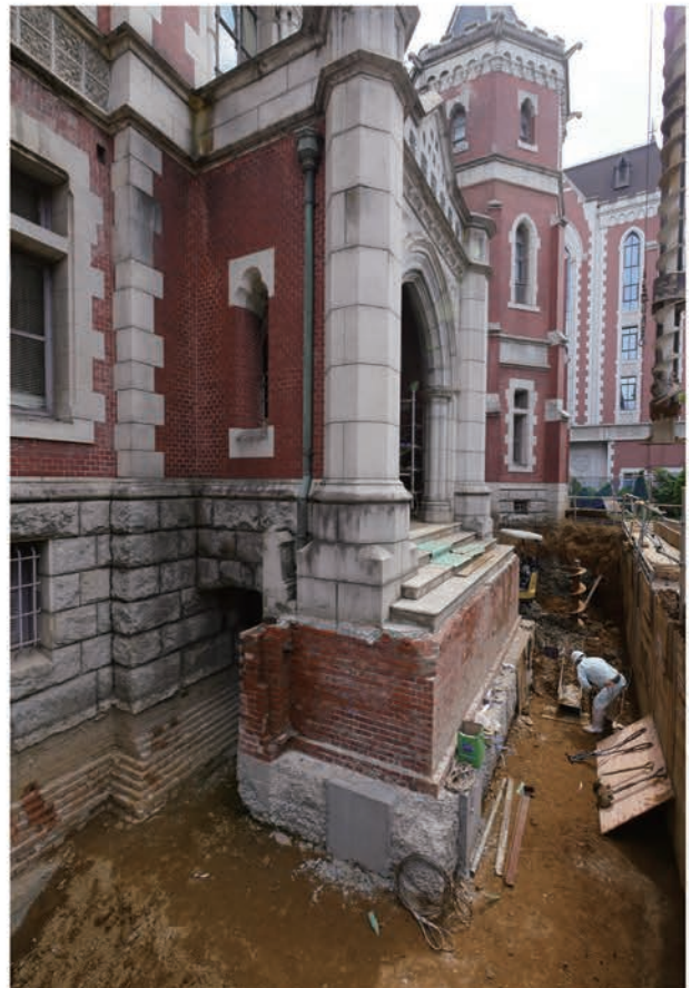
写真 4.2.20 エントランス外壁 基礎 南西から
