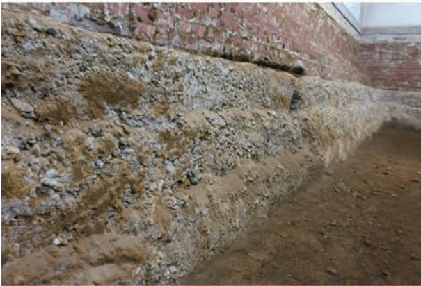
写真 4.2.16 第一書庫南室 南面布基礎
