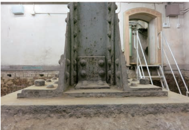
写真 4.2.10 第一書庫南室 独立基礎(東) 礎石上の鉄骨柱 南面
