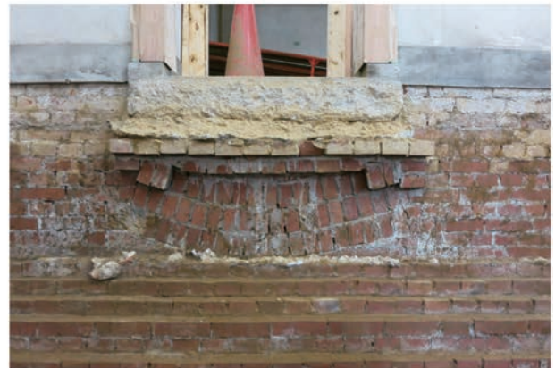
写真 4.3.8 第一書庫南室北面内壁西寄扉開口部 インバート
