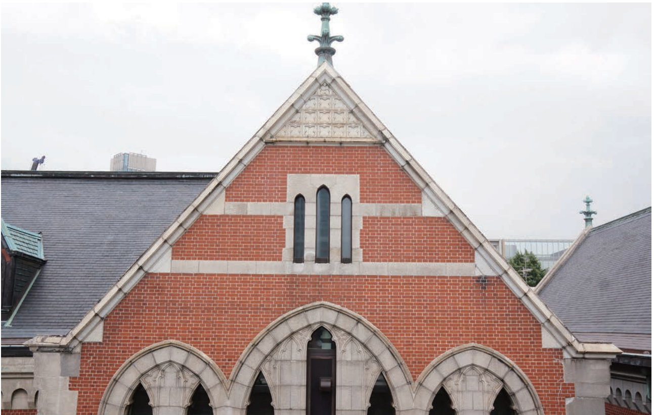
写真 4.3.6 第一書庫北面妻壁
