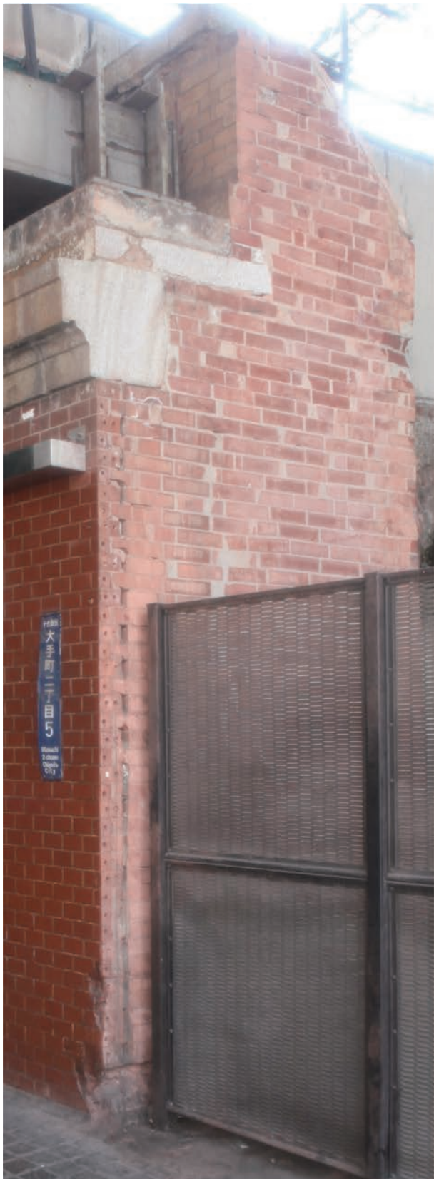
写真 4.3.3 常盤橋架道橋南橋台西側切断面
