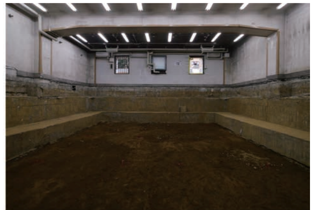
写真4.2.7 第二書庫 コンクリート基礎 北から
