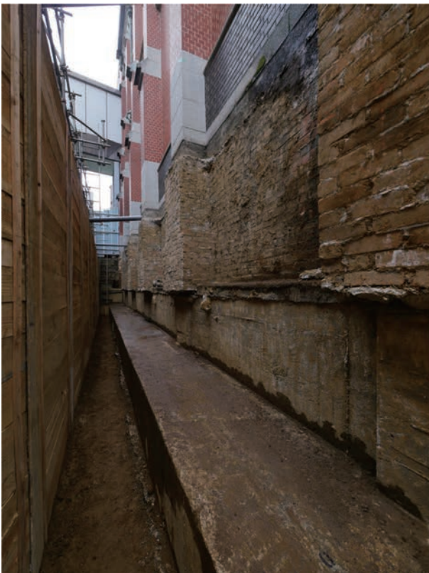
写真 4.2.22 第二書庫 西面外壁 基礎 南から
