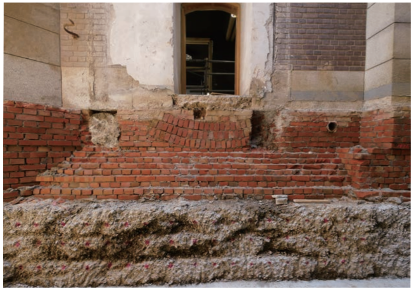
階段室 西面外壁 開口部 インポート(11-西)
