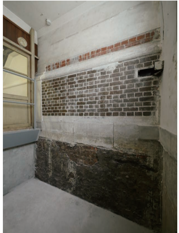
写真 4.2.21 旧館 西面南寄り壁面 建設当初の外壁仕様が現存していた
