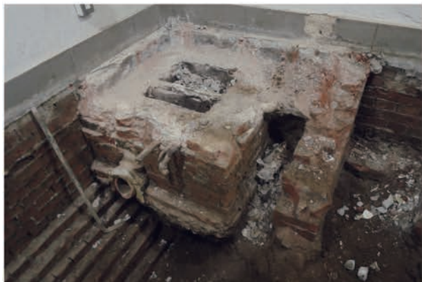
写真 4.9.14 煉瓦積貯水槽 基礎石を取り除いた状態
