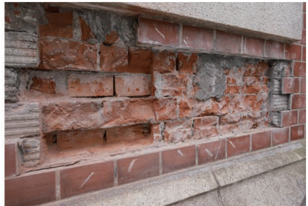
写真 4.3.2 化粧タイル背面に当初煉瓦積が残存
