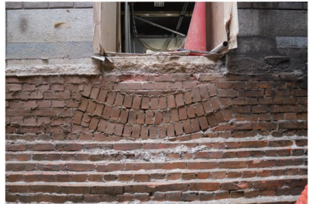
写真 4.3.9 旧館階段室北面外壁扉開口部 インバート
