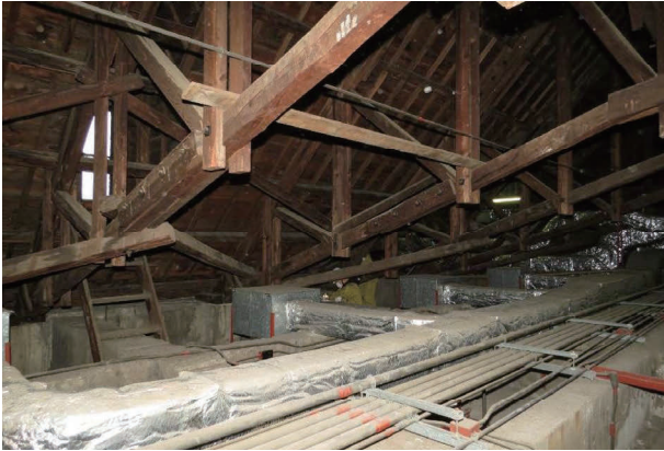
写真 2.3.3 旧館屋根裏木トラス 1
