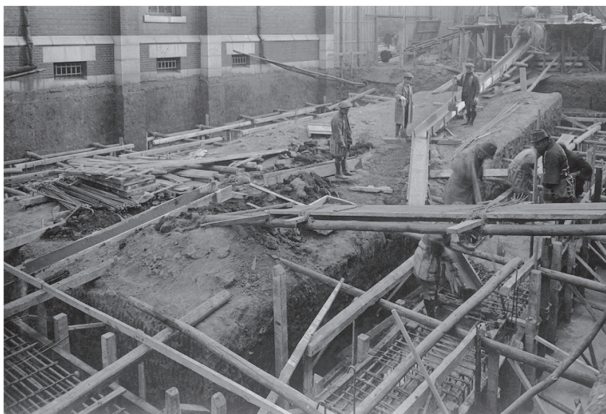
写真 2.2.1 第二書庫基礎工事
