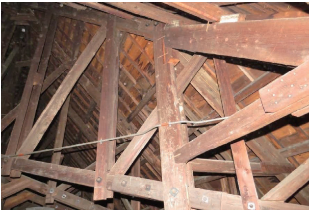
写真 2.3.4 旧館屋根裏木トラス 2
