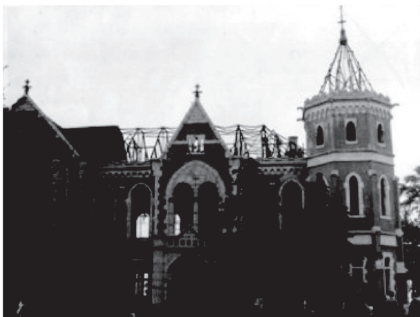
写真 2.3.2 焼損の甚だしい大階段室小屋組・窓(古写真 190)
