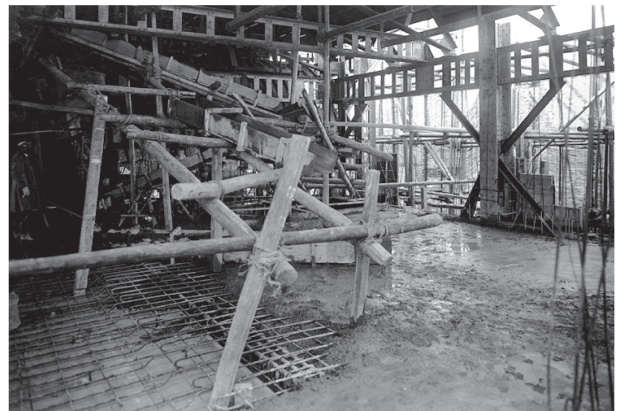
写真 2.2.6 第二書庫床コンクリート打設
