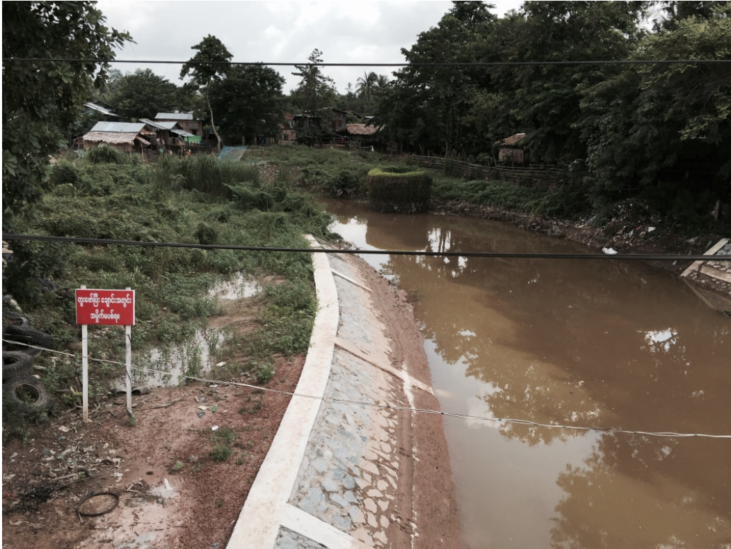
図 18 洪水対策により川幅が拡張された河川
