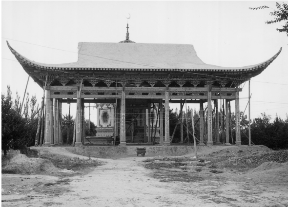
写真3 寧夏固原靈明堂分堂の建築中の宝砂と六卦
