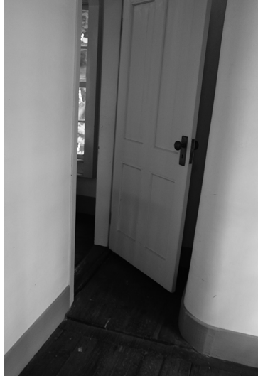
図29 東側ギャラリー北端の開き戸（開く途中で壁に当たる）
