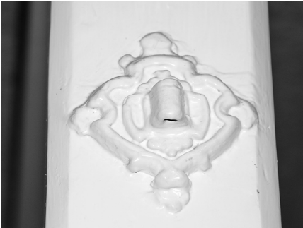
図31 会堂内支柱に残る金具
