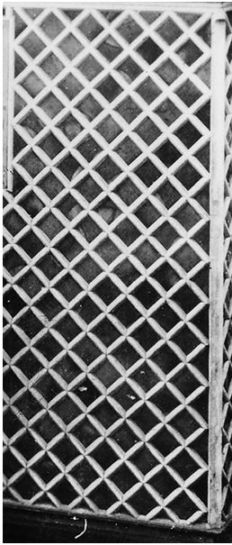
図21 移築前の演説館の海鼠壁（正面側） （図17を拡大）
