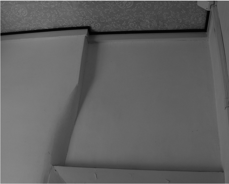
図30 東側ギャラリー南端の天井の縁取り
