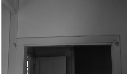
図27 南側ギャラリーの東端開口部に残る金具
