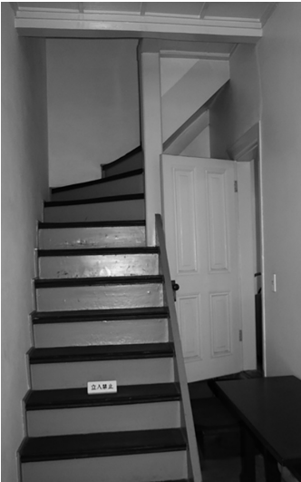
図26 土間左手（南）の開き戸（開く途中で階段側桁に当たる）
