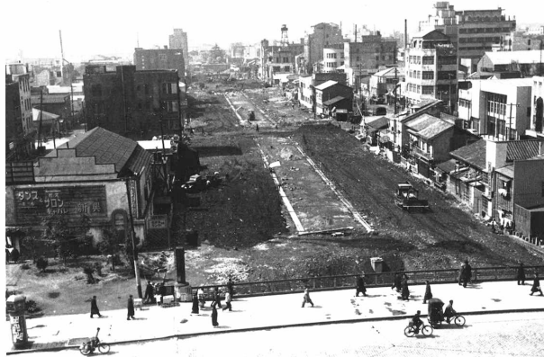
図5 三十間堀川埋め立て工事竣工直前
