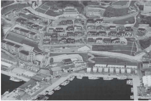
写真1 宅地造成後の玄界島（2008年3月） （『玄界島震災復興記録誌』より転載）
