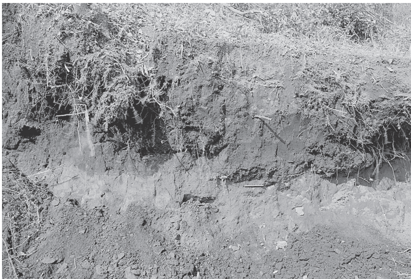
写真21 南粘土層発見時? 「二-5 鞍部盛土断面?」
