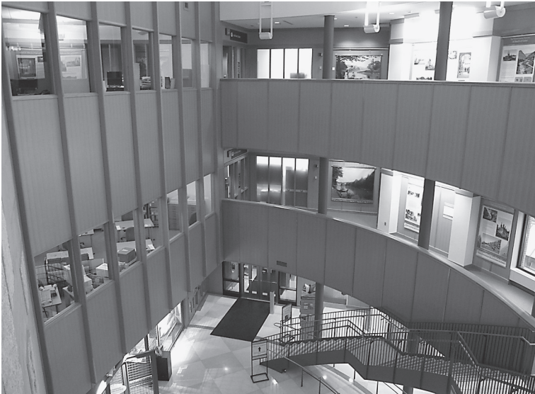
写真2 エルマー・L・アンダーセン図書館の内部 (2階左側に見えるのが閲覧室)
