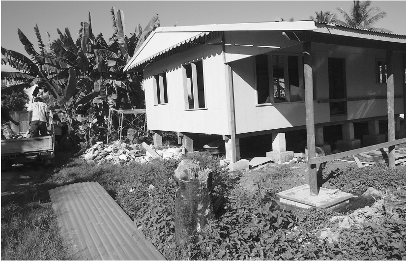
図7 サンゴ礫を敷き詰めて地盤を強化する様子 ※ 調査対象地区の「滑走路側」セクションにて、
