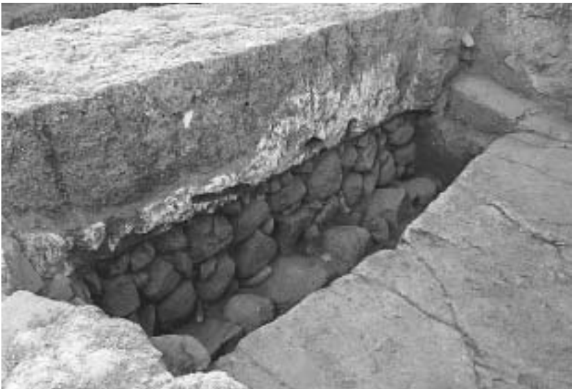
写真1 L17で検出された壁
