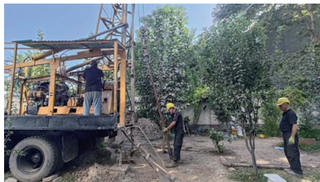
図2 タジキスタンにおけるGSHP用の熱交換井掘削の様子 日本よりも技術的に遅れており、タジキスタンでは約50年前の技術で井戸の掘削を行っている。日本との技術ギャップを埋めるためのコミュニケーションが重要となる。 写真提供：日本地下水開発(株)、2023年8月3日撮影
