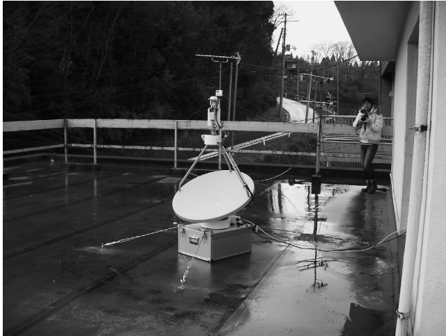
図7 気仙沼市唐桑総合支所に設置されたライフラインステーション
