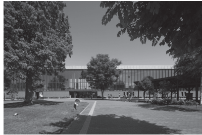
写真1 岩見沢複合駅舎（北海道岩見沢市）
