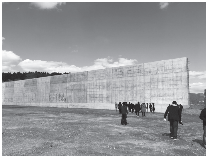
写真1 陸前高田市に建設中の防潮堤。12m
