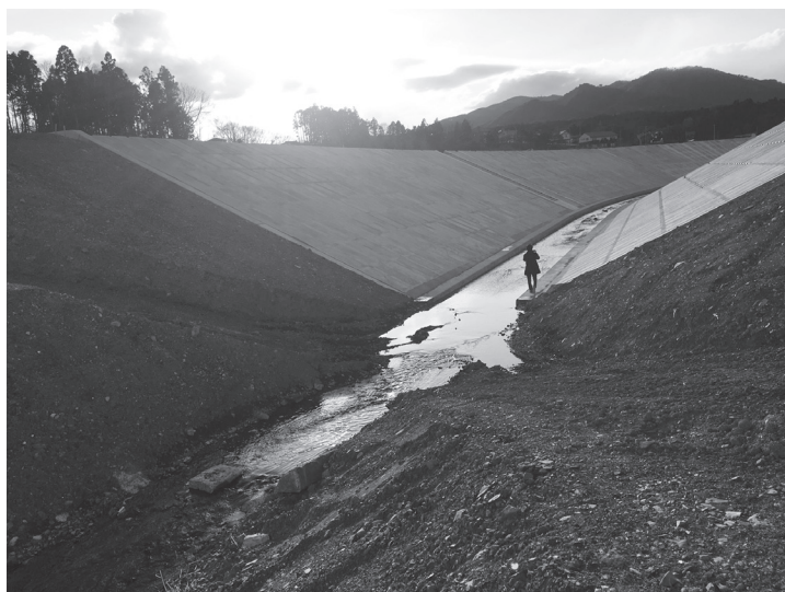
写真2 気仙沼市の沖の田川に建設中の河川堤防。9m
