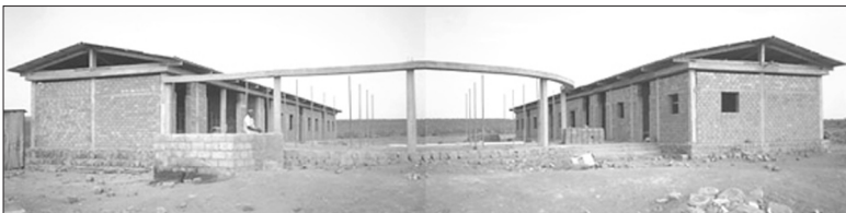
図 2 PK20 小学校外観 (2003 年 6 月)
