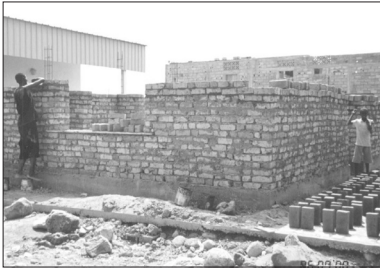
図 11 実験棟煉瓦積み上げ作業
