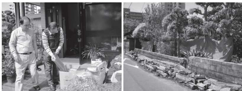
写真2 K氏の自宅での崩落した塀へのブルーシートを使用した応急目張り作業の様子
